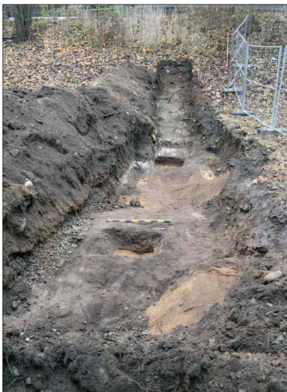
Figur 33. Schakt 10 i Enskede Gård vid Gullmarsplan. De två provgroparna grävdes genom odlingslagret 1001 och under vidtog orörd mark med fin sand. Fotograferat från öst.
