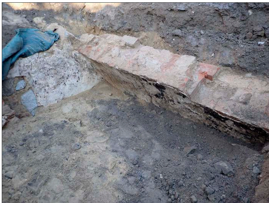
Figur 10. Fortsättningen på murverket, här ett delvis framschaktat tunnvalv (112:2). Notera den igenmurade öppningen längst till vänster i bild. Foto från SO.
