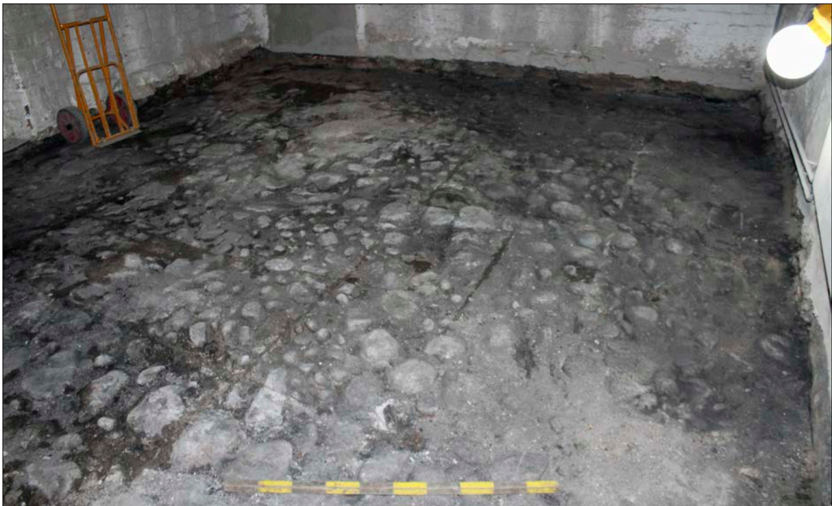
Figur 4. Stenlagt golv rum 580. Golv av samma karaktär återfanns även i rum 581. Foto från norr.
