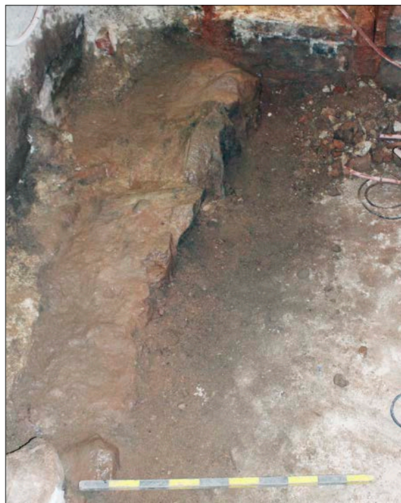
Figur 14. Stödmur 302, i rum 583, antagligen samtida med övrig byggnation då material och byggt teknik överensstämmer. Foto från väst.
