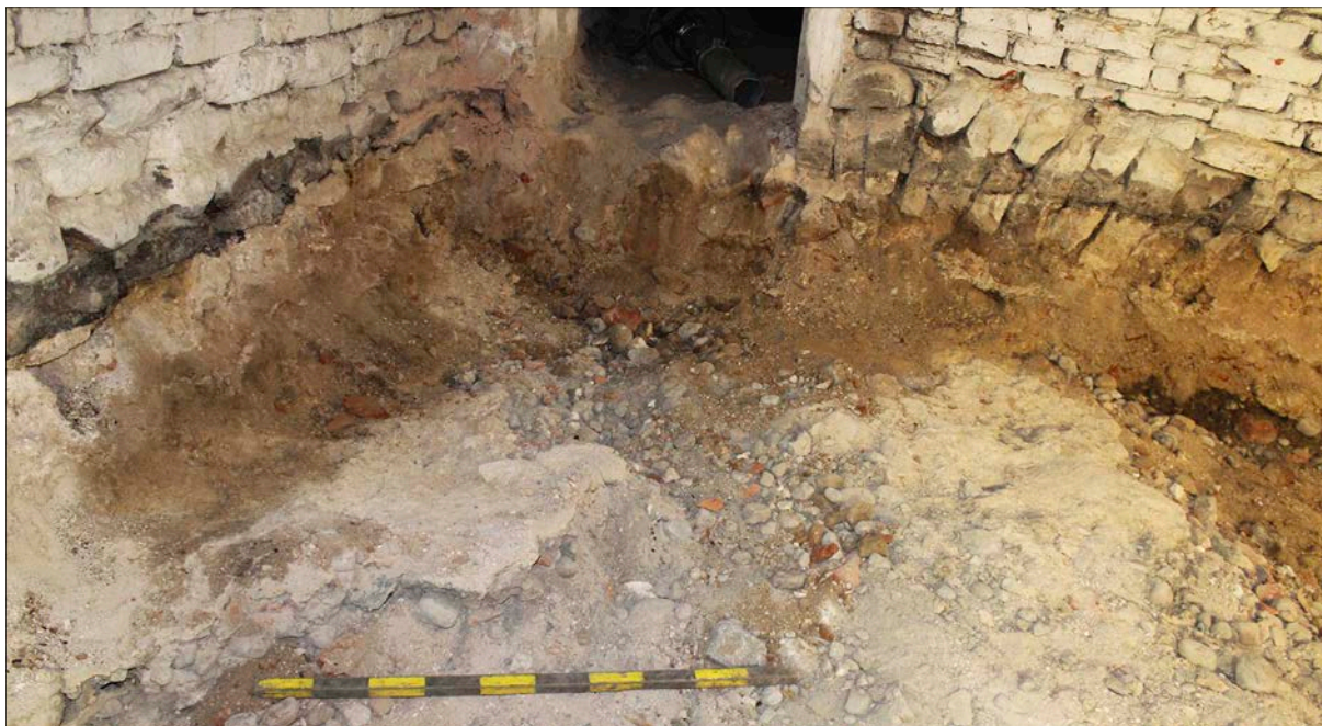
Figur 9. Lager 204, ett mycket kompakt kalkbrukslager som var bäst bevarat längs väggarna och i mitten av rummet 581. Notera även förstärkningsbågen i den nedersta delen av den högra väggen. Foto från nordost.
