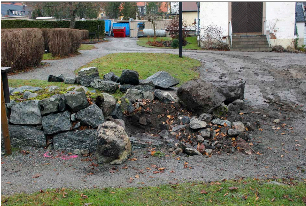
Figur 5. Större insatser vid passage i den norra sträckan av kyrkogårdsmuren, muren plockades ned till nedgrävda grundstenar. Foto från söder.
