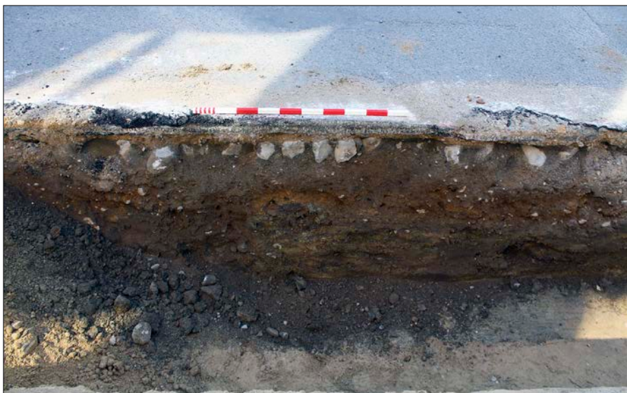
Figur 7. Schaktvägg med kullerstengata (100), underliggande bärlager (101), och utfyllnadslager (102). Foto från norr.
