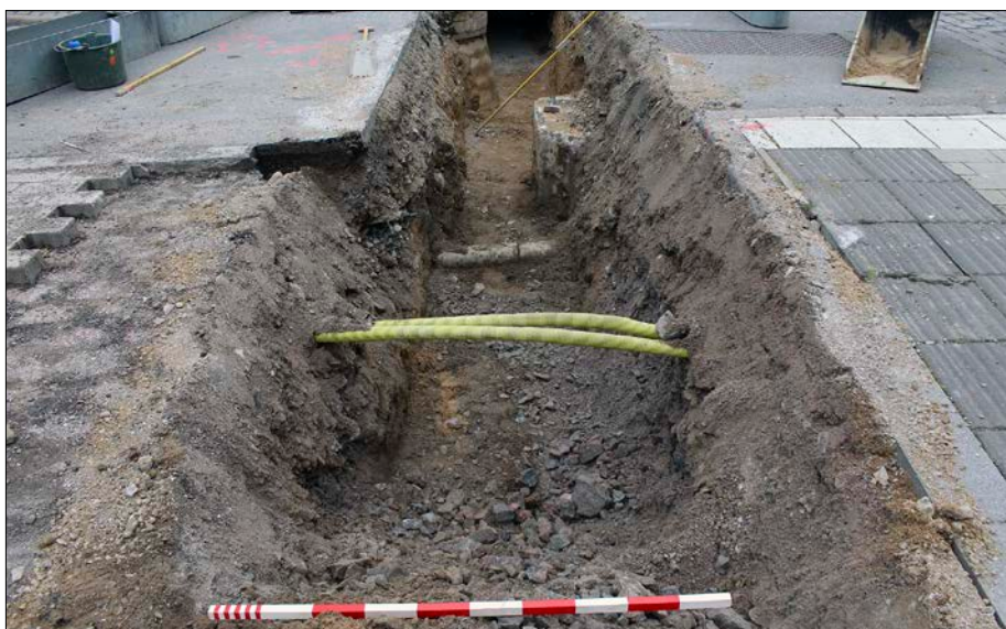
Figur 8. Störning i den västra delen av schaktet. Foto från väster.
