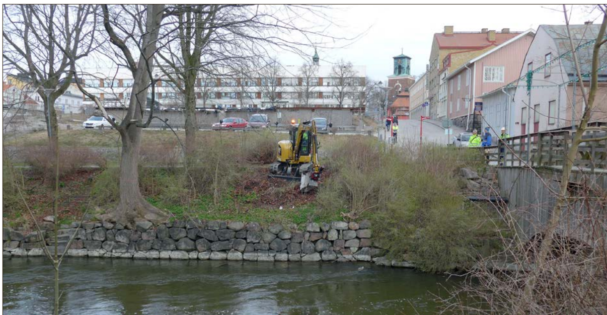
Figur 4. Rensning av vegetation inför provgropsgrävning med Behmbron till höger i bild.
