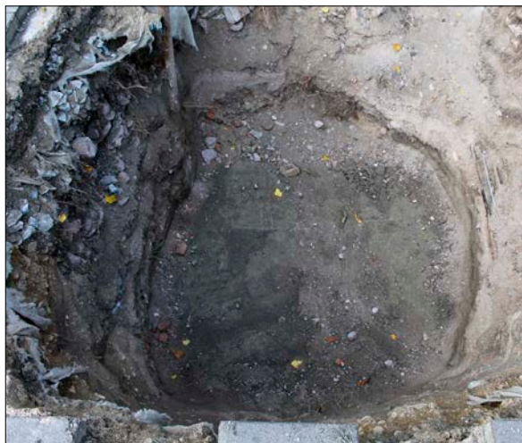
Figur 5. Schaktets sydöstra del grävdes 1,75 meter djupt. I den nedre delen påträffades ett utfyllnadslager (101) och därunder i botten framträdde blålera. Foto från ostnordost.
