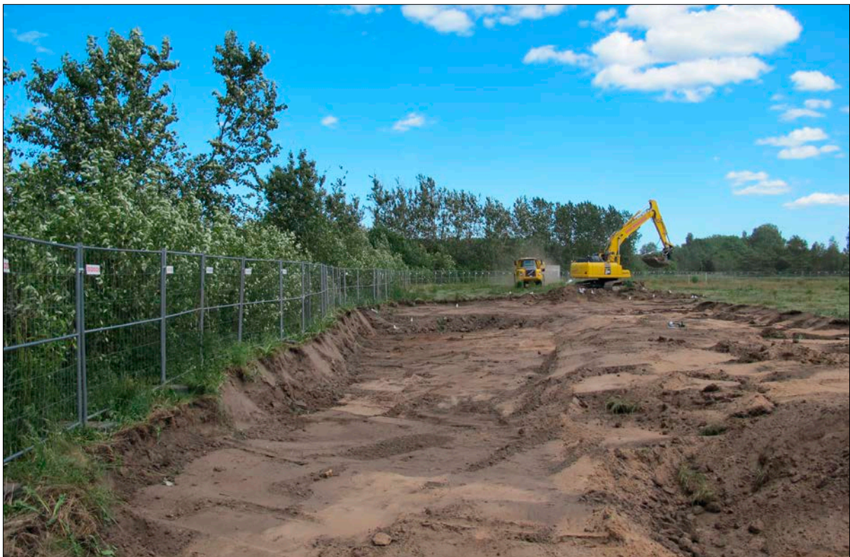
Figur 16. Avbaningen av utfyllnadsmassorna i full gång. Foto från väster.
