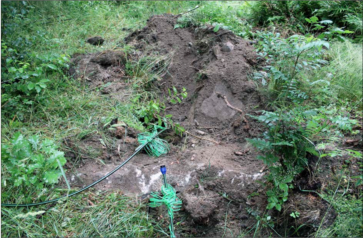
Figur 4. Schakt 502. Foto från sydöst
