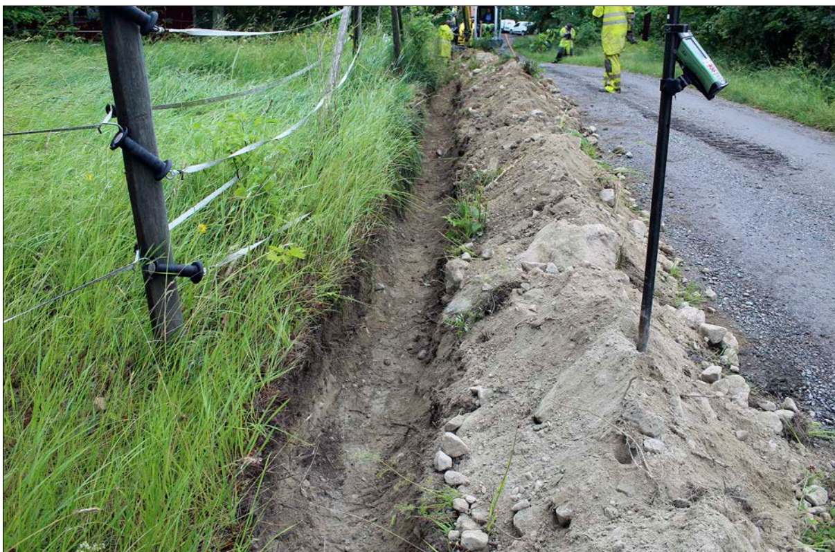
Figur 5. Schakt 503. Foto från nordväst.
