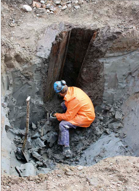
Figur 33. I brunnsnedgrävningen hade stående plankor placerats för att skapa ett rektangulärt brunnskar. Foto från V.
