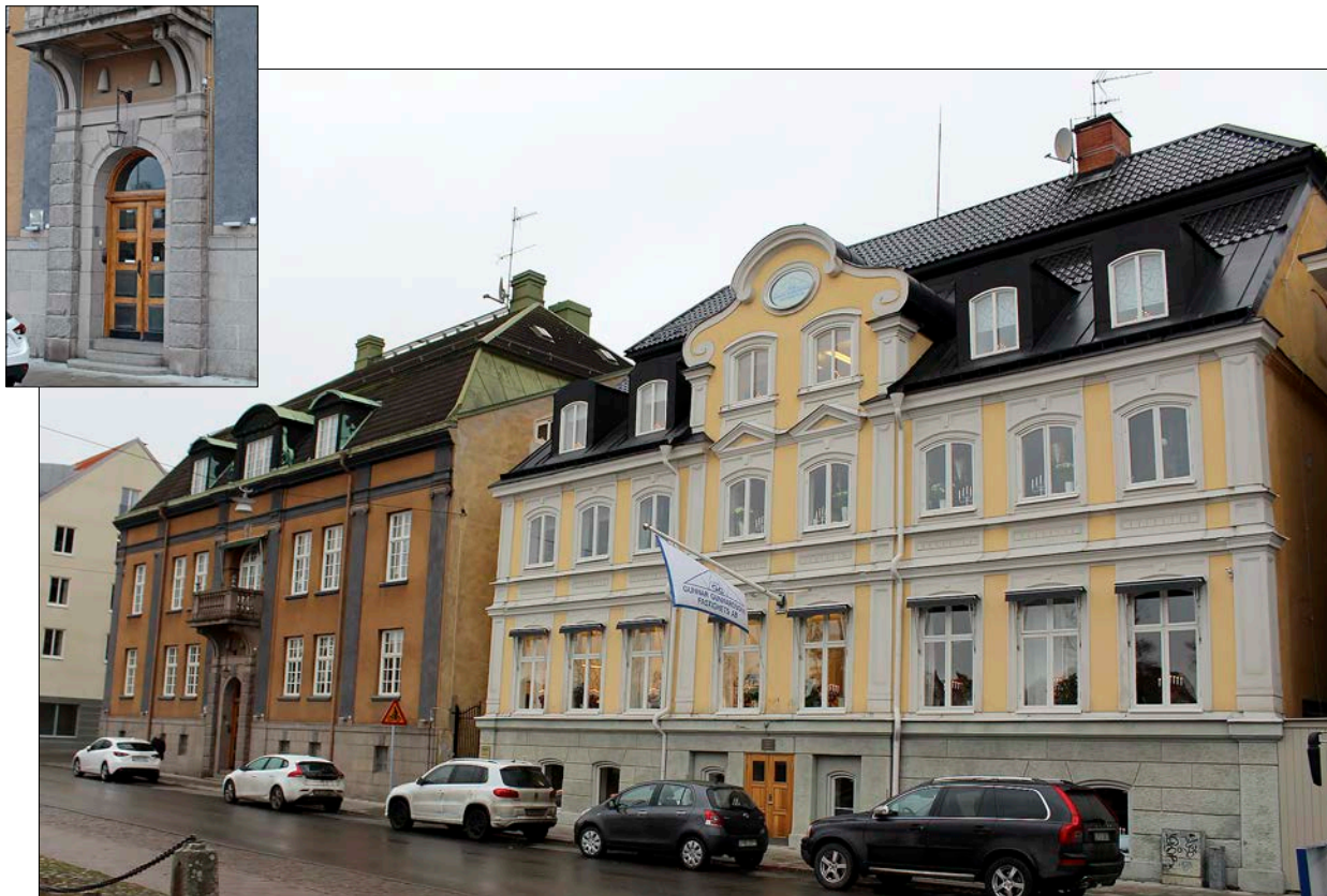
Figur 7. Saltängsgatan idag. Den privatbostad som Rode lät bygga finns fortfarande kvar (till höger). Till vänster syns den Appeltofftska villan, byggd där själva bruksbyggnaden en gång stod. Till minne av sockerbruksverksamheten på platsen utsmäckades byggnaden med två sockertoppar ovanför porten (se infälld bild). Foto från sydost.
