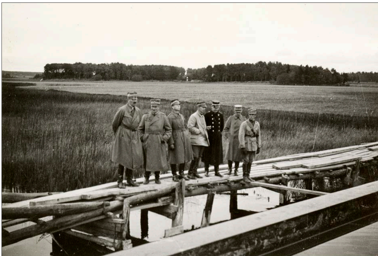
Figur 4. Militären byggde en ny träbro över Fyrisån mellan 1925–1930. I det ursprungliga fotoalbumet står orden "Brobyggnad i Storvreta under mötet 1931. Brobygget inspekterades av kårchef." I bakgrunden kan man se gärdet som var föremål för den aktuella arkeologiska utredningens delyta C. Källa: Armémuseets arkiv, ID-nr AMA.0017151 (PDM).
