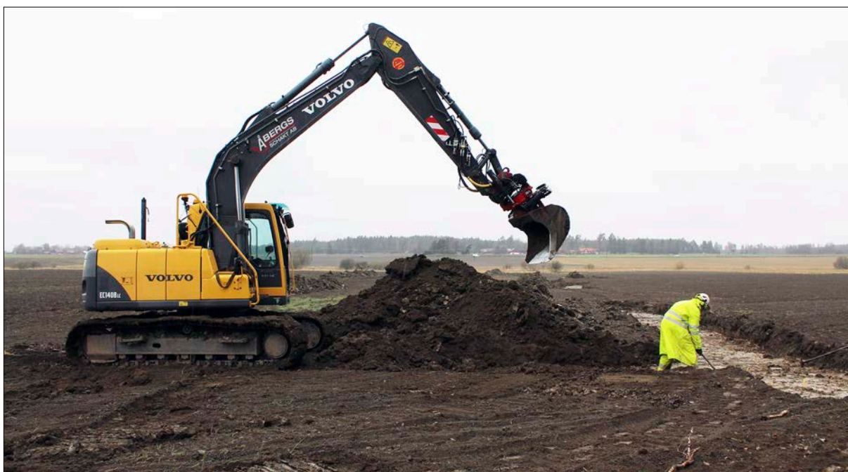
Figur 6. Schaktning pågår vid delyta C i regnväder. Foto från sydöst.
