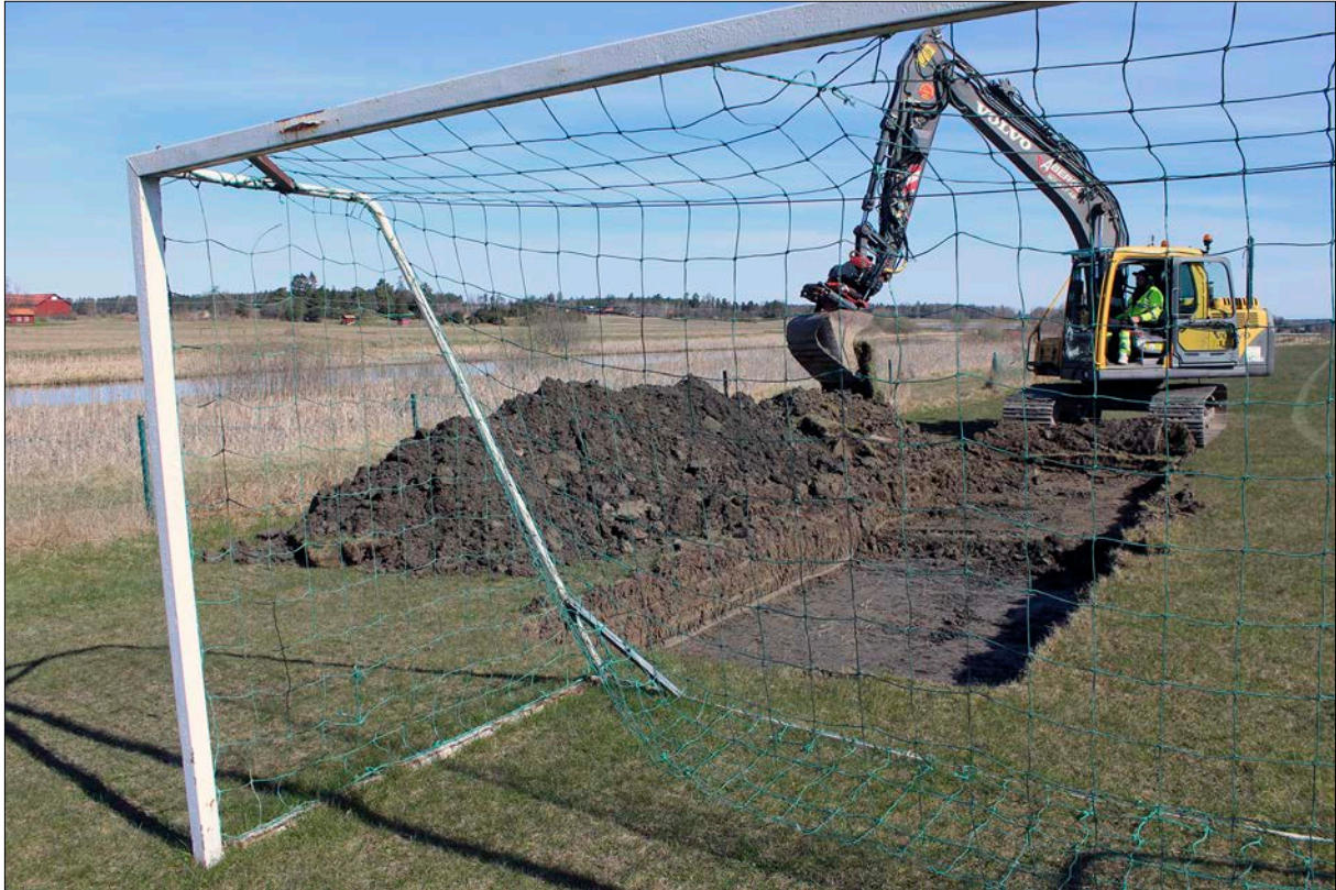
Figur 14. Schaktning på den södra delen av delyta A. Fyrisån syns i bakgrunden. I området fanns flera fotbollsmål uppställda. Foto från söder.
