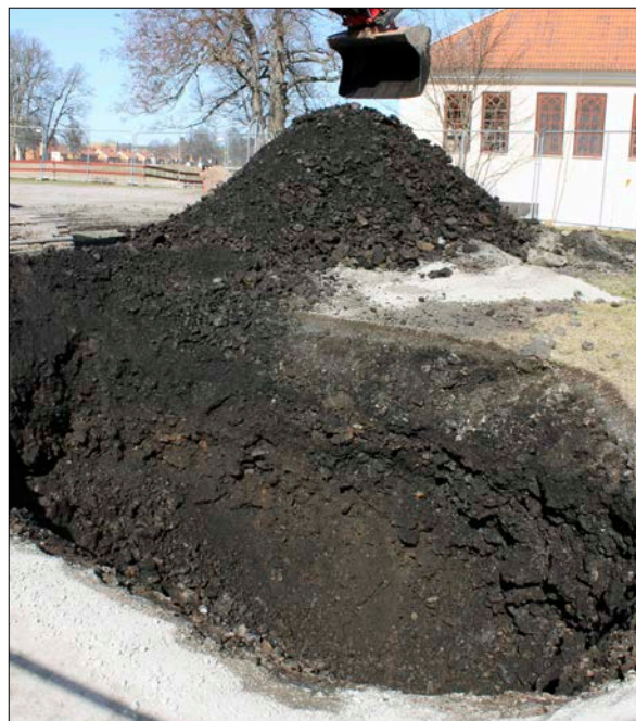
Figur 10. Sektion i schakt 1002. I bakgrunden syns schaktmassorna som i huvudsak utgjordes av masugnsslagg och lite järnmalm. Foto från sydöst.
