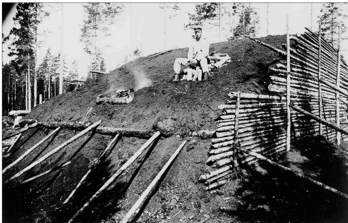
Figur 13. Bilden visar hur en liggmila som var klar för tändning kunde se ut i Bjurfors i Västmanland år 1918. På bilden syns de stöttande väggar och slanor som använts för att hålla virket och täckningen på plats. Källa: SLU:s externa mediabank, bild-id: 13636.
