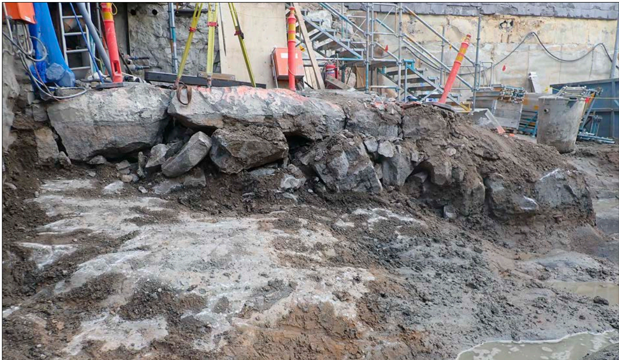
Figur 7. Grundmur uppförd direkt på berget. Foto från öster.
