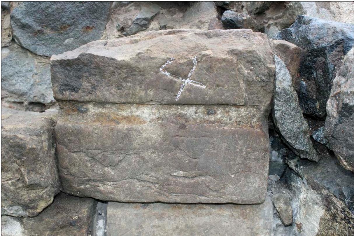
Figur 169. Flera av stenarna längs rännans kant var återanvända sandstenar med inristade märken. Här syns ett X- eller timglasliknande tecken som förtydligats med krita. Foto från norr.
