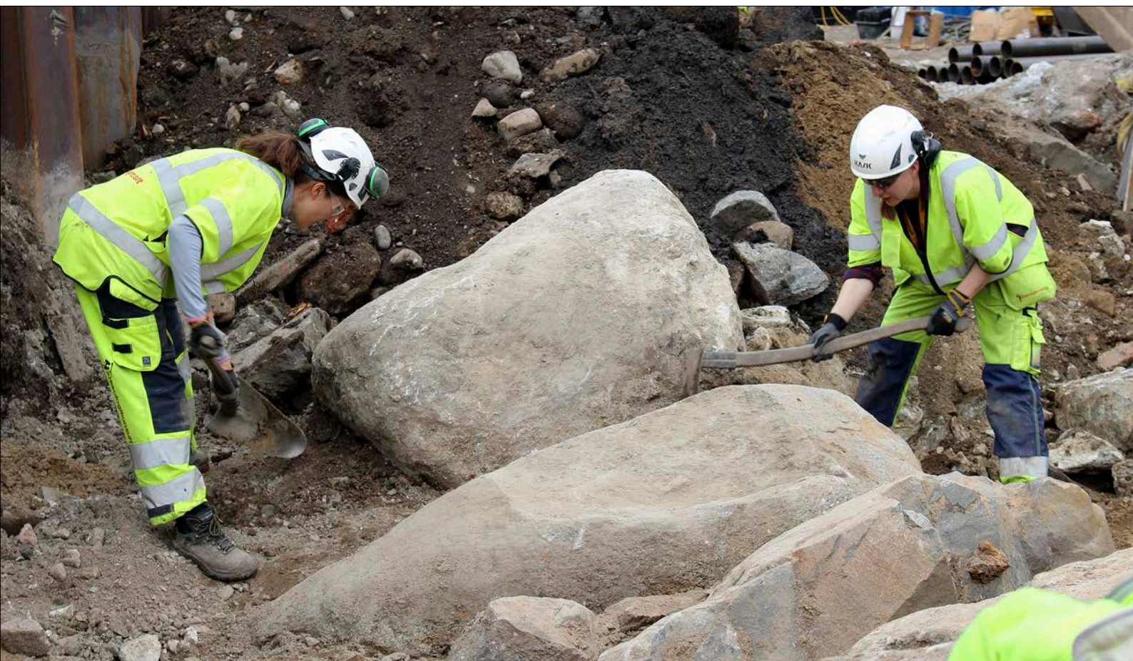
Figur 16. Här rensas några av de upp till två meter stora stenblocken som ingick i grundmuren till Vallen från 1500-talet fram. Foto från söder.
