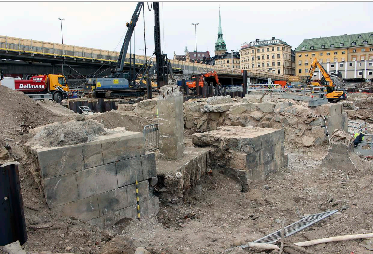
Figur 206. På bilden ses en del av kajfronten mot öster genombruten av 1930-talets betongkonstruktioner. Foto taget från sydöst.
