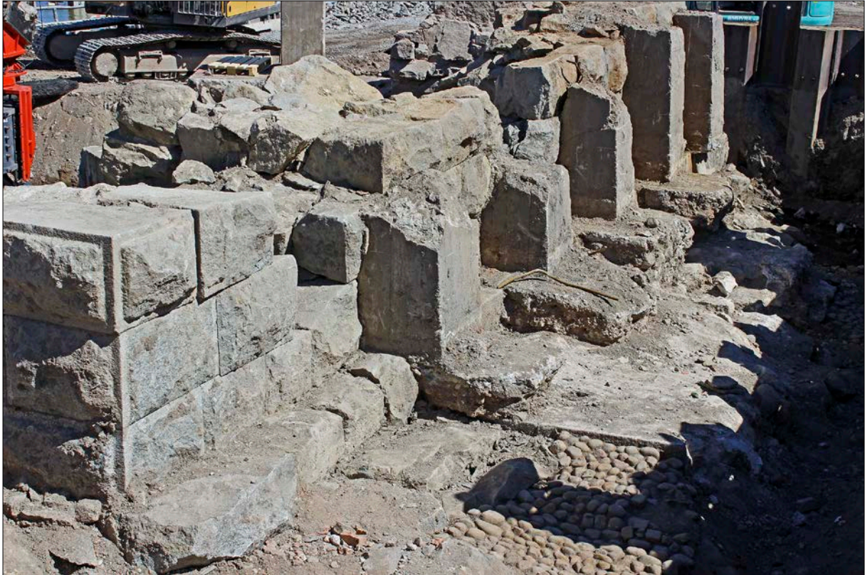
Figur 197. Muren sedd från sydväst. Längst till vänster syns den senare tillbyggda murdelen (2613) med något avvikande form på stenarna. Framför muren står betongfundament från 1930-talets trafikapparat och till höger syns grundmuren från fas 5 samt stenläggningen kontextgrupp 33.
