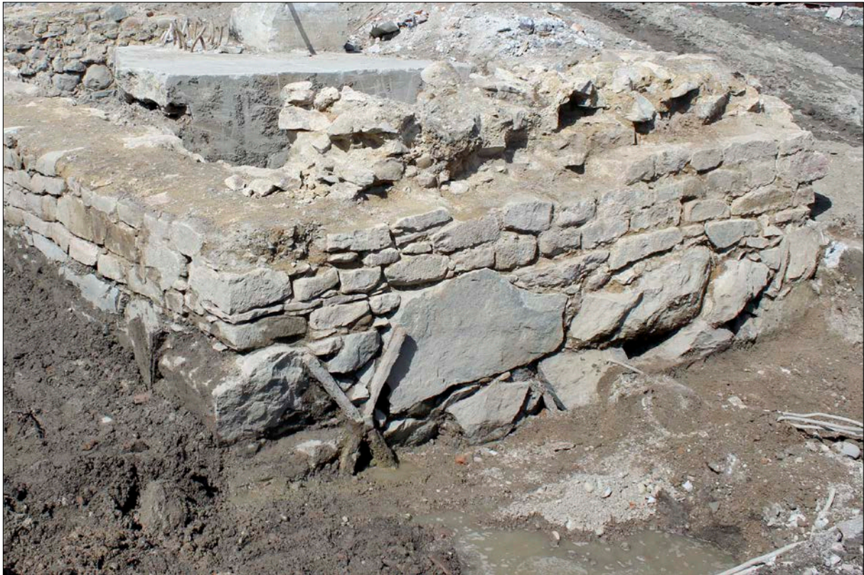
Figur 128. Välbevarade delar av källaren i kontextgrupp 21 framtagna. Foto från sydöst.
