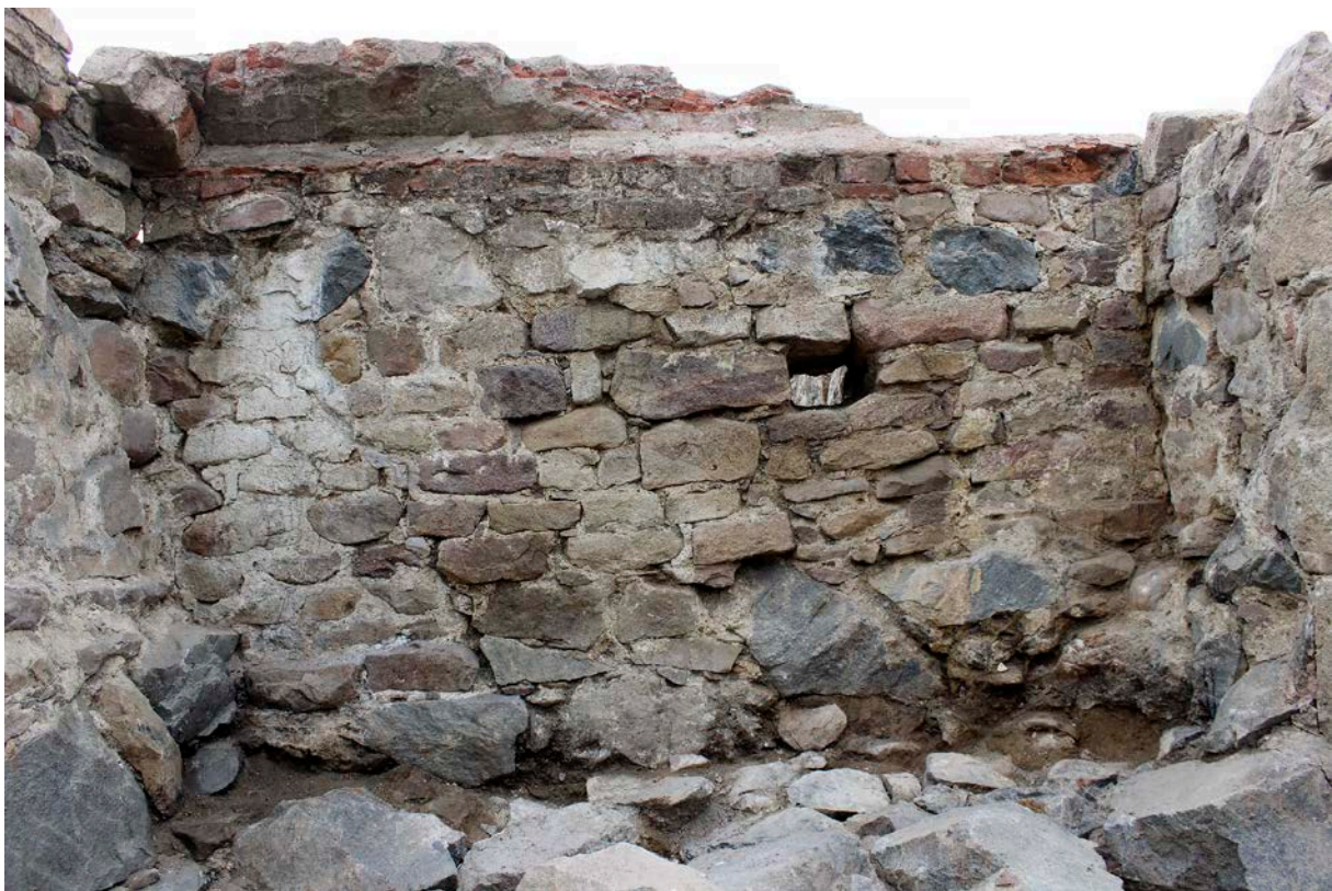
Figur 139. Mellanväggen i källaren var uppbyggd med natursten.
