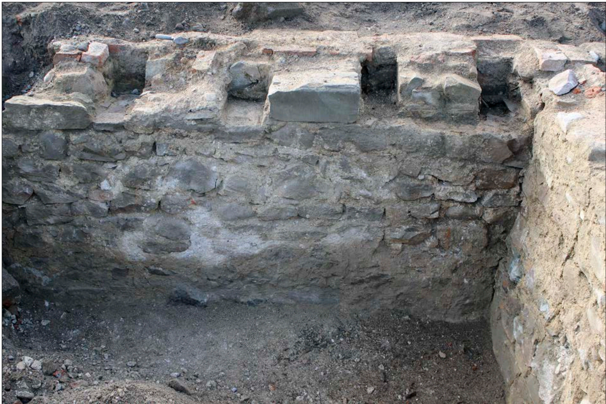
Figur 131. Urtagen för bjälklag till källarens tak fanns bevarade på den södra källarmuren. Foto från norr.
