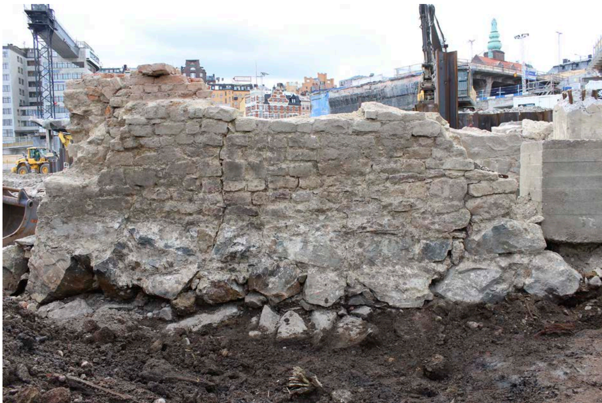
Figur 140. På bilden ses hur ytermurarna till källarna var konstruerade, med kraftiga naturstenar i botten och mindre tuktad sten längre upp. Foto från norr.
