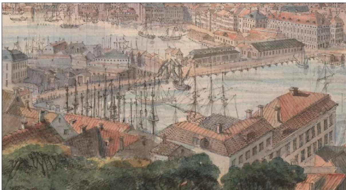
Figur 119. Den här vyn över Södra Slussplan skapades av Johan Fredrik Martin 1789 och visar hur området såg ut innan de stora ombyggnationerna under 1800-talets första hälft (alvin:portal:record-85880, Public Domain Mark). Bilden är beskuren.
