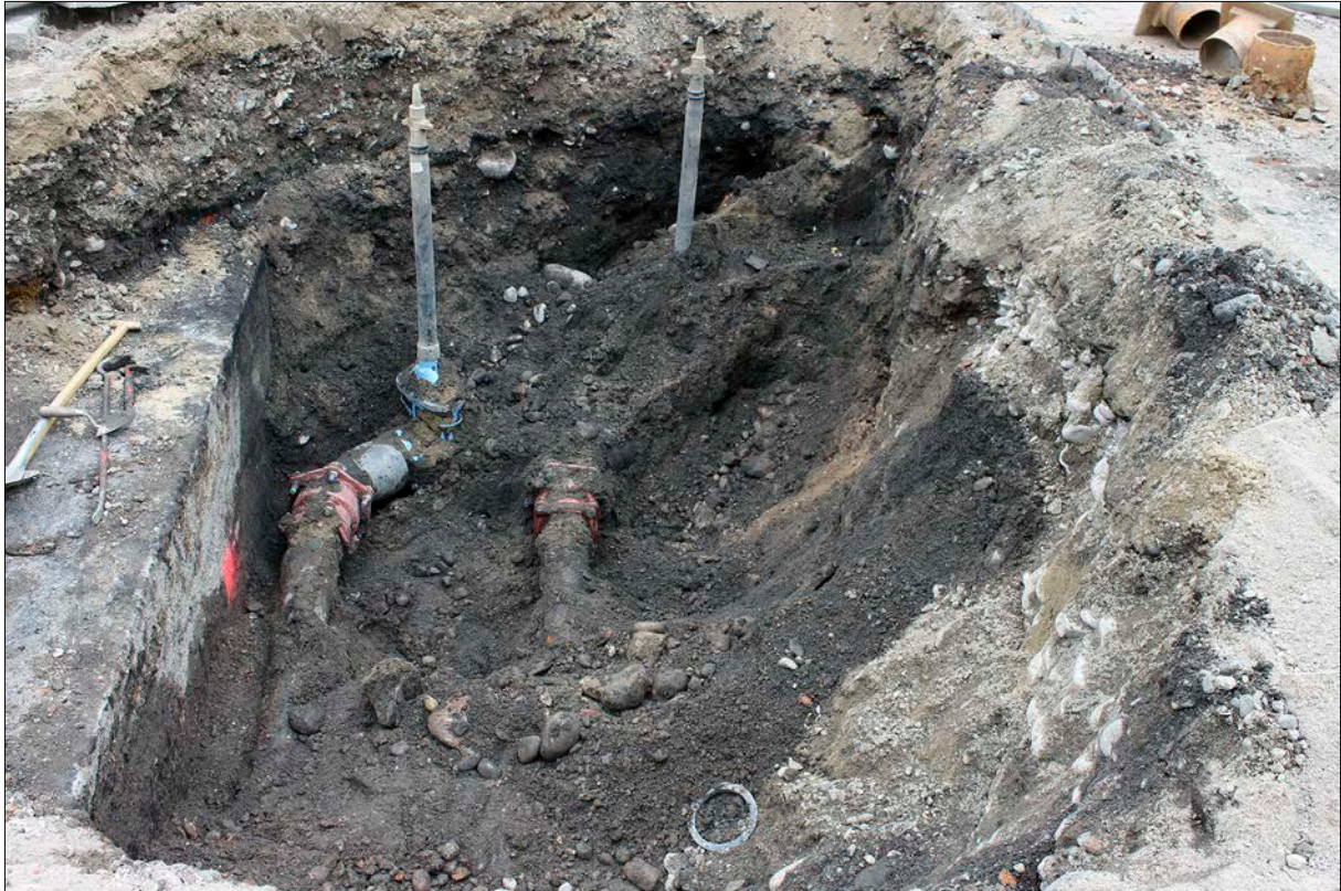
Figur 4. Översikt över schakt 100. Betongkulverten kan ses i vänstra delen av bilden. Foto från norr.
