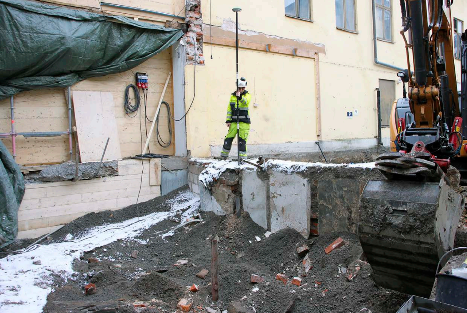
Figur 38. Bilden visar källare 2, som var fylld av stora mängder grus och rasing. Foto från sydöst.
