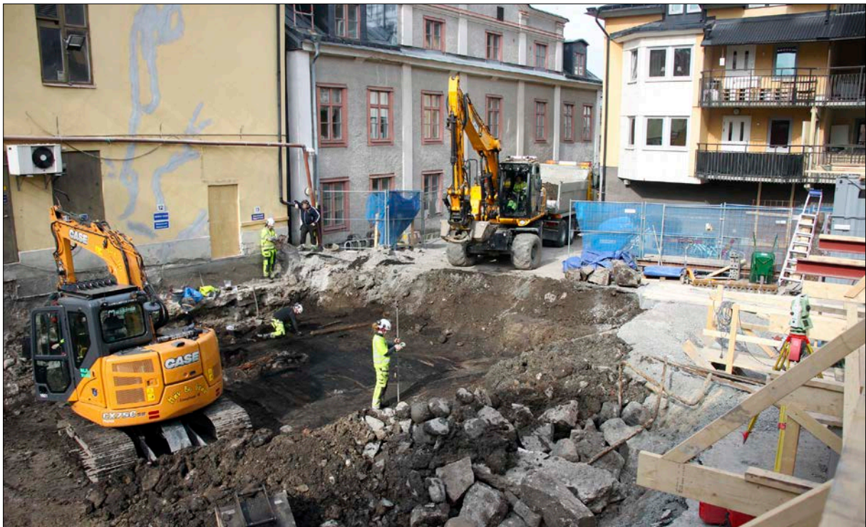
Figur 7. Schaktningsövervakning och pågående byggnation. Samtidigt som de arkeologiska lämningarna dokumenterades pågick bygget runtomkring.
