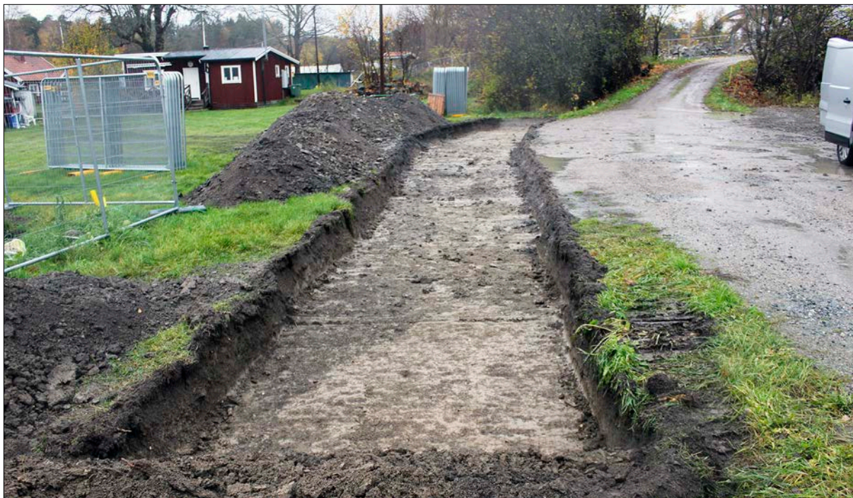
Figur 14. Schakt 4 nedgrävt till orörd mark. Foto från söder.
