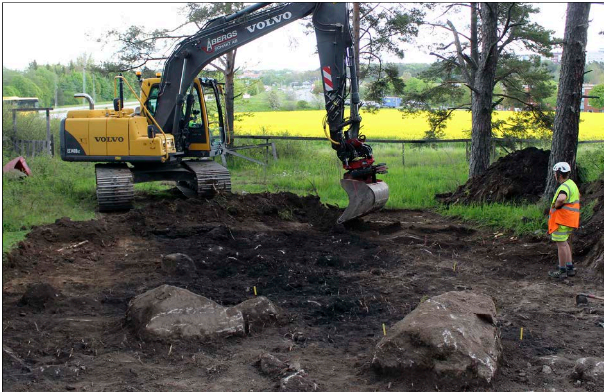
Figur 7. Den tre meter stora härdens schaktas fram.
