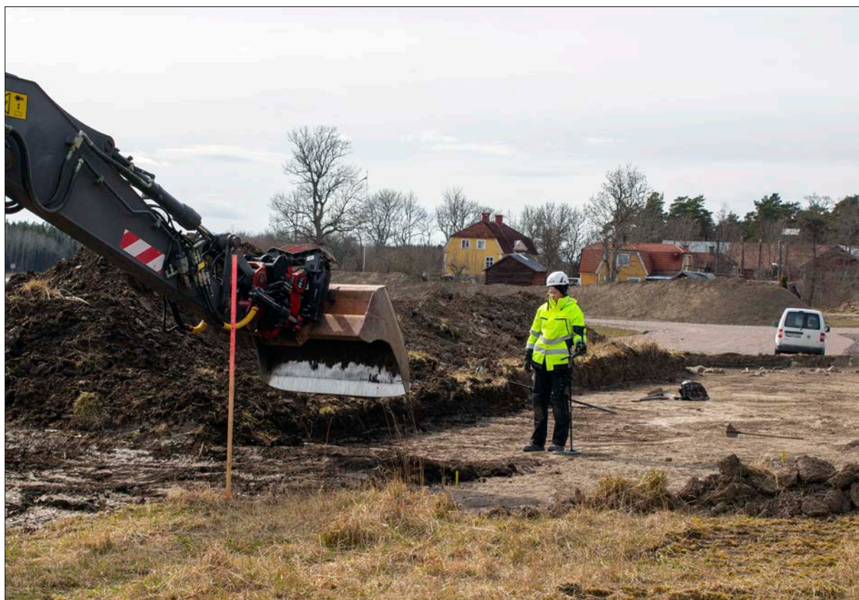
Figur 4. Matjordsavbaning med grävmaskin. Foto från öster.
