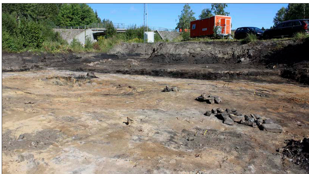
Figur 30. Material hade lagts på undergrunden för att skapa en plan yta. Foto från söder.
