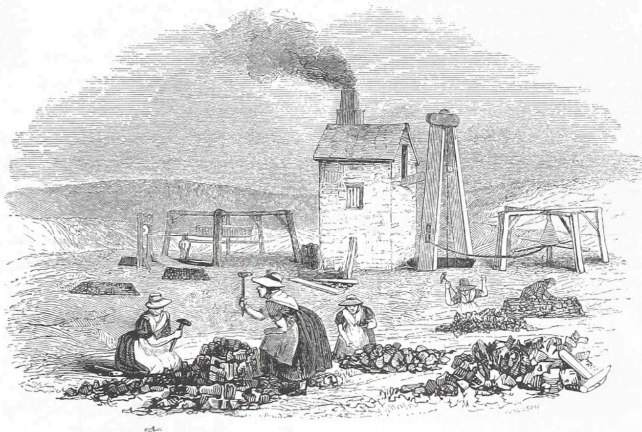
Figur 52. Kvinnor bokar kopparmalm vid en koppargruva i Cornwall, Storbritannien. Ur "An illustrated Itinerary of the County of Cornwall" av Cyrus Redding. British Library's catalogue Bild-id 014828091. Public Domain.
