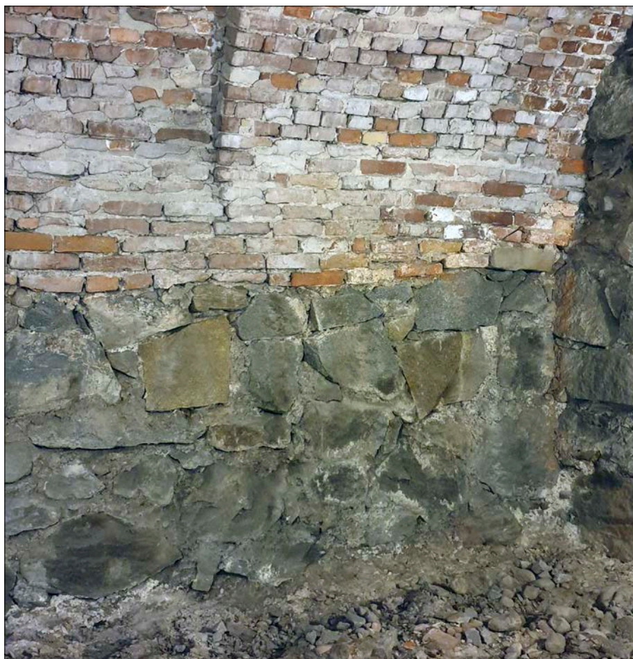
Figur 3. Grundmuren och delar av valvet i den västra delen av källaren. På golvet syns fragment av betong och ett sandigt bärlager samt rullstenar och lite tegel inne i hörnet. Foto från sydost.
