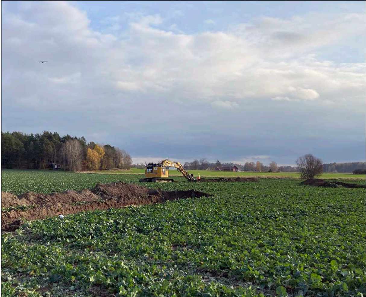
Figur 7. Sökschaktning inom L1939:1605, där åkern vid undersökningstillfället var beväxt med höstsådd raps. Ett flygplan går samtidigt in för landning på Uppsala Ärna flygplats. Foto från nordväst.
