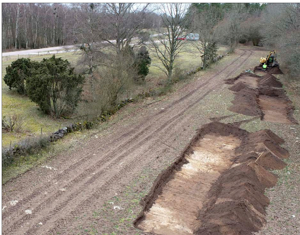
Figur 8. Delområde 4 samt den södra delen av gravfältet L1957:9316 under pågående sökschaktning. Närmast i bild är schakt 1026. Fotograferat med drönare från norr.
