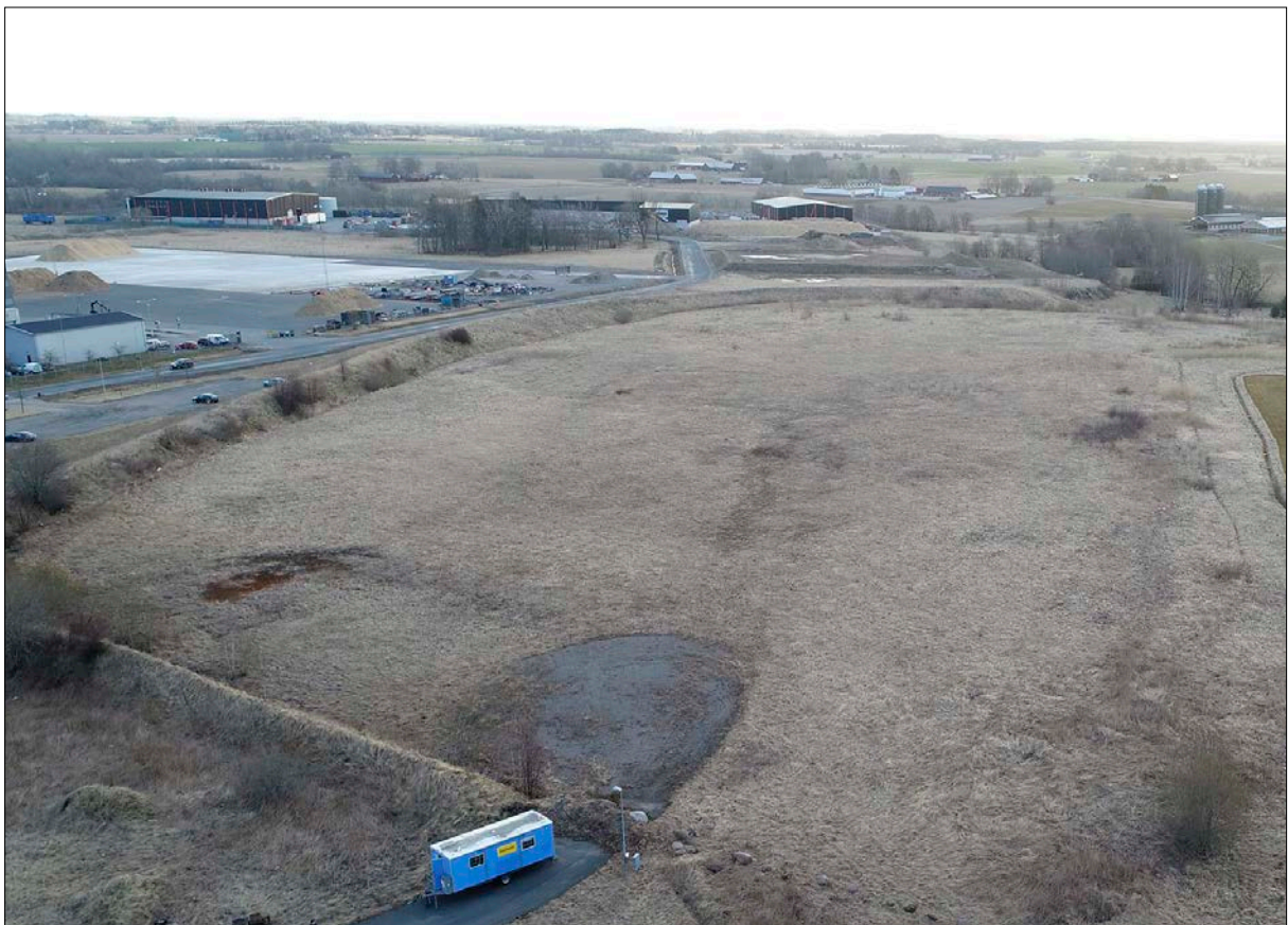
Figur 6. Utredningsområdets norra del. Den långa byggnad som påträffades vid undersökningen 2007 hade ungefär samma placering som den stora industribyggnaden till höger i bildens övre del. Foto från väster.
