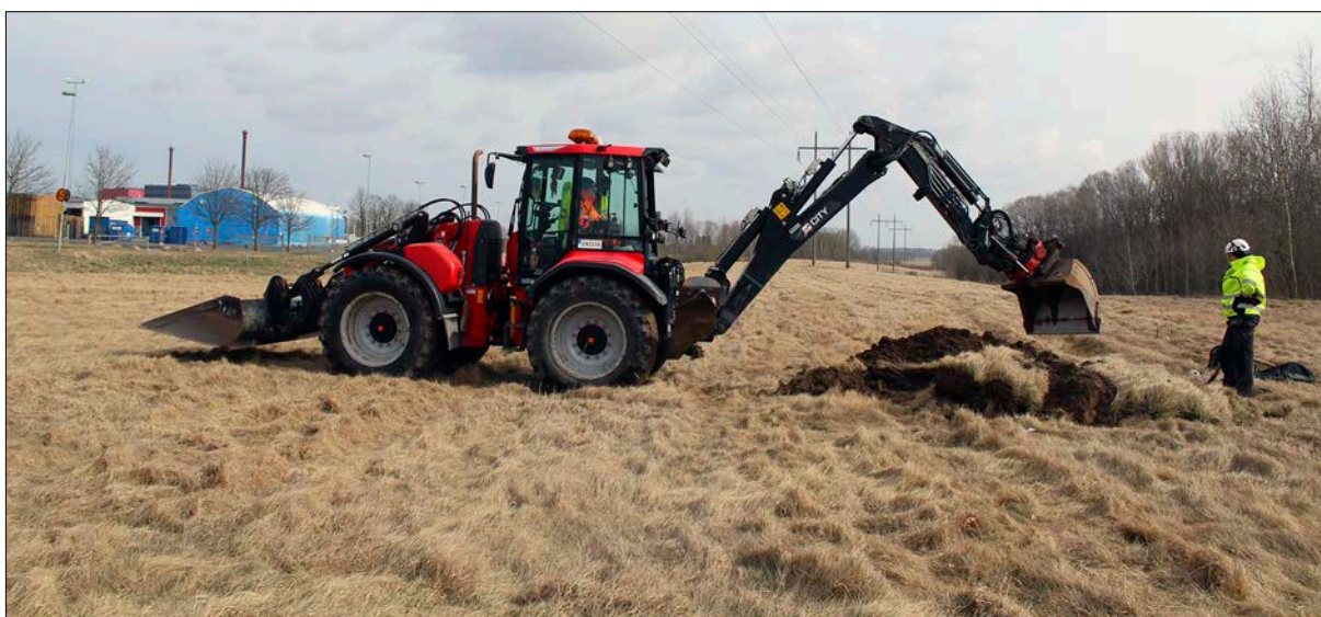
Figur 3. Sökschaktning i utredningsområdets västra del. Foto från väster.
