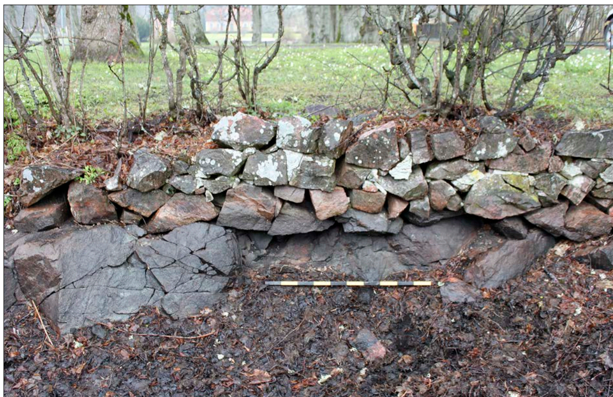
Figur 26. Del av stensatt kant till vattenrännan söder om schakt 4, västra kanten. Foto från öst.
