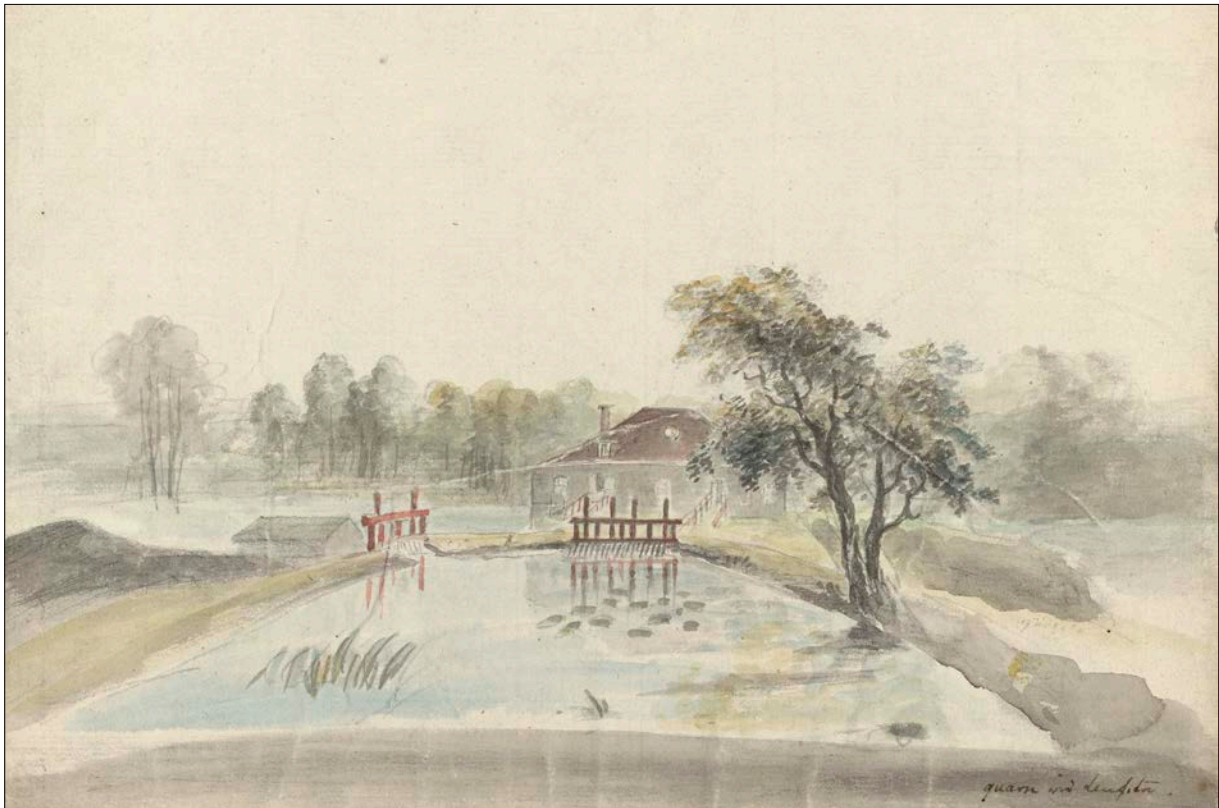
Figur 12. Målning av Elias Martin (1739–1818) Quarn vid Leufsta . Uppskattningsvis från omkring 1795. I förgrunden syns kvarndammen med utlopp ner i Mellandammen samt inlopp till den kvarn som byggdes 1773 (Övre kvarnen). Källa Alvin-portal.org. Bildsök-id 4170. Bilden är beskuren.
