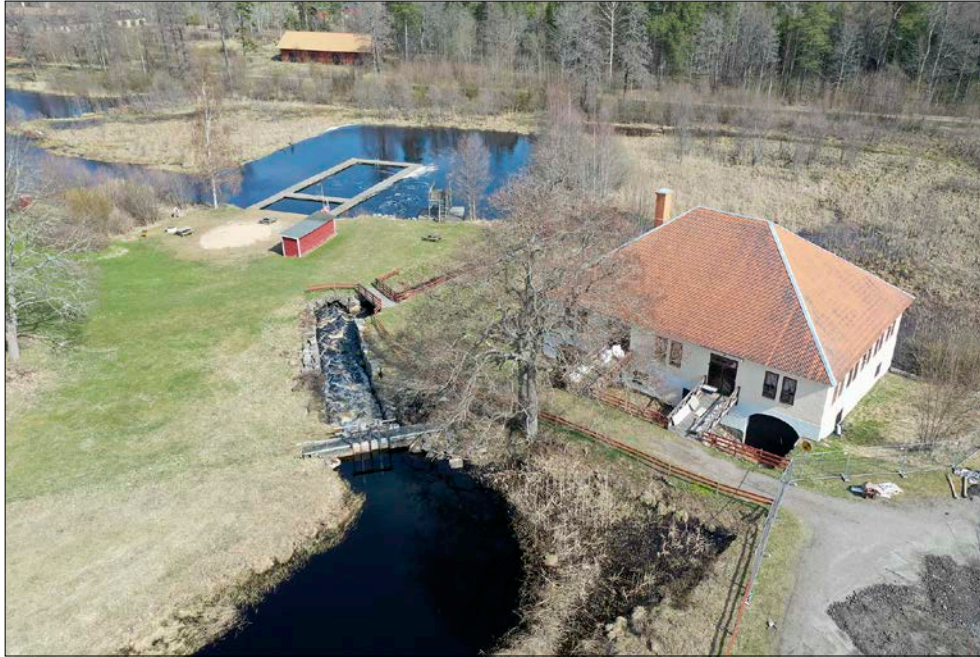
Figur 37. Undersökningsområdet vid schakt 8 och 9 innan vattnet i kvarndammen omdirigerats. Foto från sydväst.
