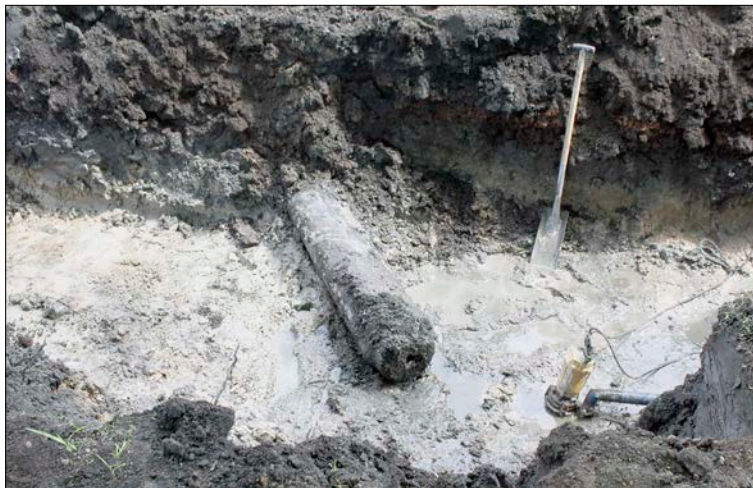
Figur 30. Trätrumma 109. Vatten fortsatte att rinna ur trumman flera timmar efter att den tagits fram. Foto från väst.
