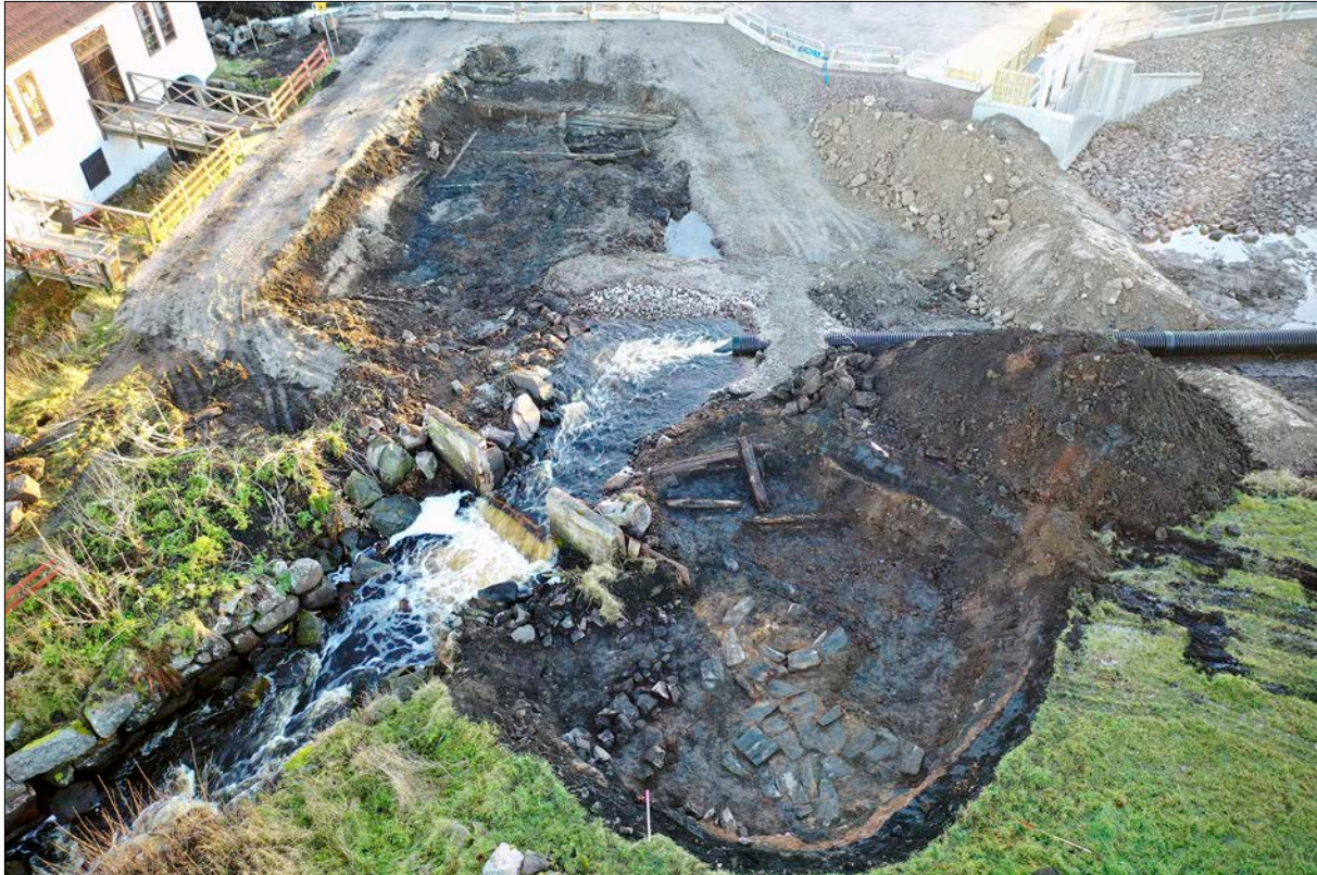
Figur 48. Schakt 8 och 9 grävdes parallellt vilket försvårade arbetet. I förgrunden syns schakt 9 och stengolv 134 samt de översta stockarna i dammkonstruktionen 141. Foto från norr.
