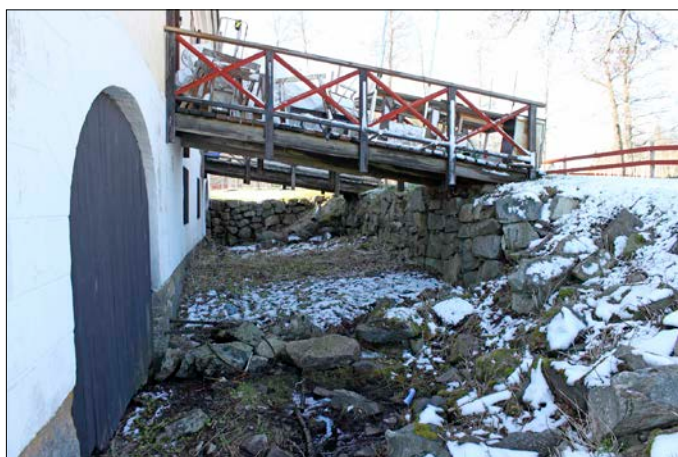
Figur 41. Under den träbro som leder in till kvarnen syns samma stenfundament som stenkonstruktionen 167 tillhör. Längst bort i bild syns den stensatta kanten 128. Foto från norr.
