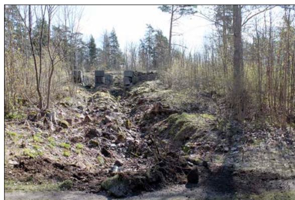
Figur 15. Vattenrännans östra del var stensatt och bildade tre fåror. Vid undersökningstillfället var rännan torrlagd. I bildens nederkant syns den tidigare vattentrumman i plast som lett vatten under befintlig väg. Foto från väst.
