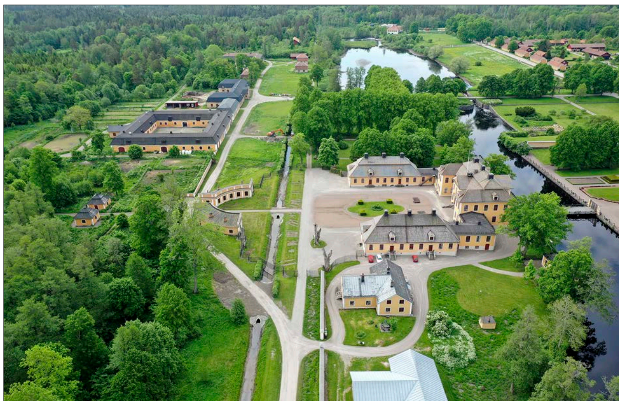
Figur 23. Översikt efter att nya betongtrummor byggs där schakt 2, 3 och 4 grävdes. Foto från norr.
