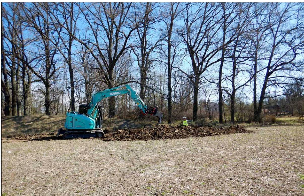
Figur 8. Sökschaktning i åkermark. I bakgrunden ansas huvudbyggnaden till Bärby gård. Foto från väst.
