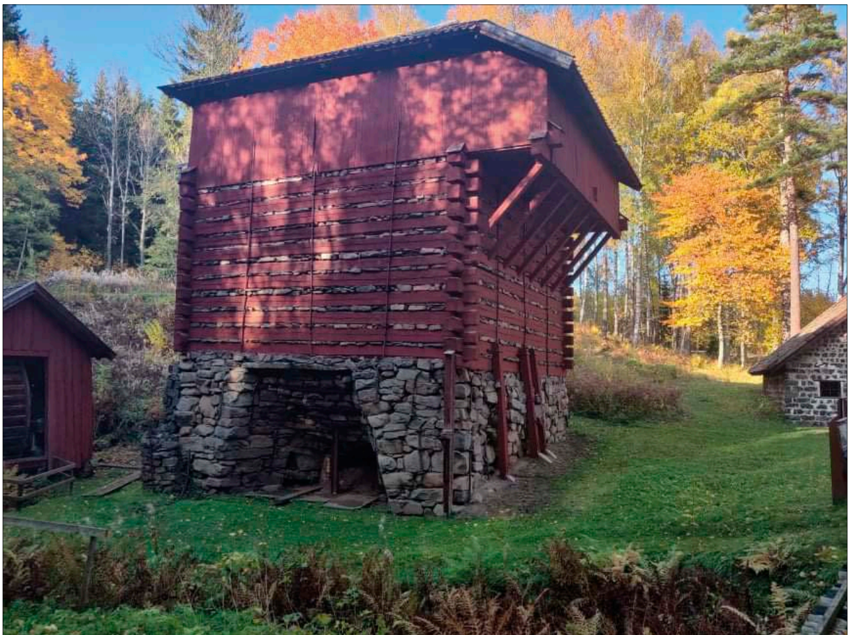
Figur 10. Den restaurerade masugnen vid sjön Trehörningen i Mariedamm, cirka 1 mil norr om de aktuella kolningsanläggningarna. I masugnen tillverkades tackjärn som sedan togs till Godegårds bruk för omarbetning till stångjärn. Masugnen lades ned år 1889. Foto av Niklas Einarsson.
