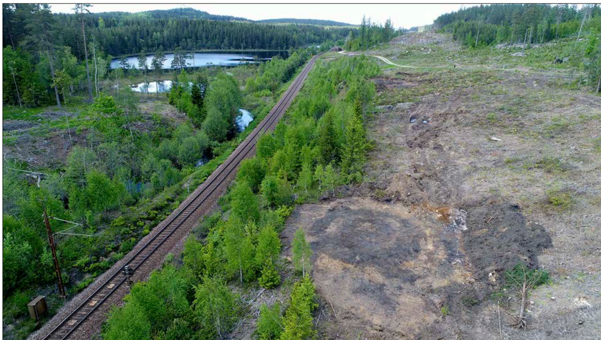
Figur 25. Lämning L2008:6195 i förgrunden. Något längre bak i bild anas L2008:6073. Den enkelspåriga järnvägen som ska byggas ut sträcker sig till väster i bild parallellt med Godegårdsån. Längre bort i bild finns Unnagölen. Foto från söder.
