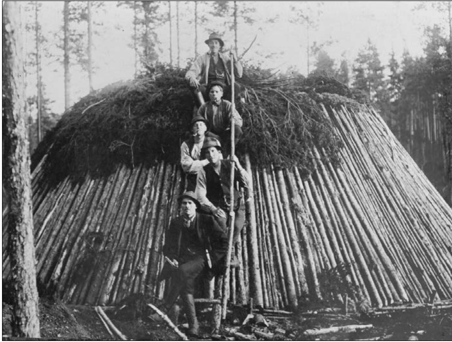
Figur 12. Ett arbetslag med kolare som håller på att klä en resmila med mossa och ris. Fotograf: okänd. Källa: Digitaltmuseum, id-nr: XLM.Fågelsjö150 (CC-BY-NC).
