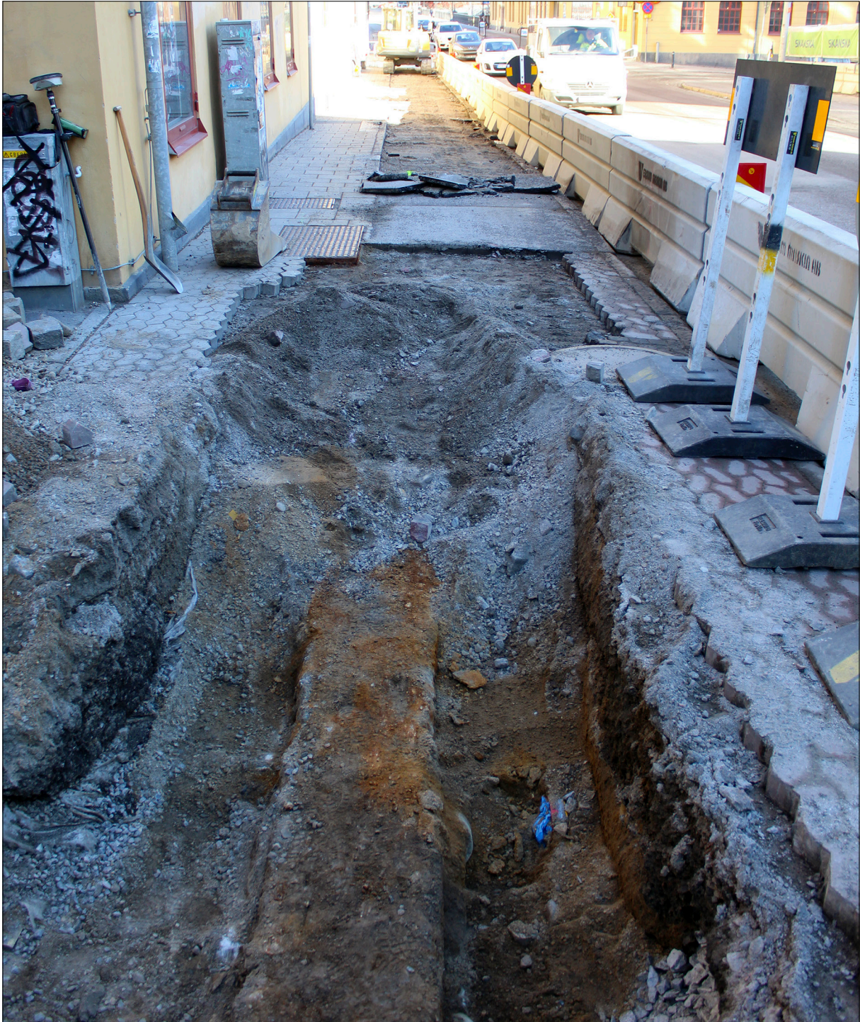
Figur 10. Schakt 2 under arbetets gång. Foto från sydsydväst.
