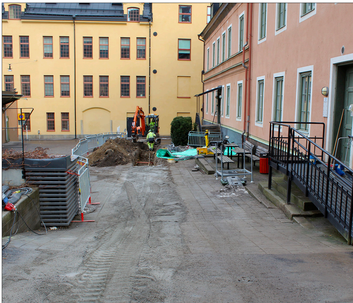
Figur 6. Schakt 1 under arbetets gång. Foto från sydväst.
