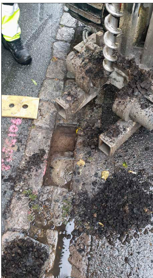
Figur 3. Borrpunkt 106 placerades i befintlig rännsten. Bilden ger en fingervisning om hur stor yta som påverkades i samband med provborringen – och hur det kan bli när en regnskur drar in i samband med borringen. På marken ligger material som kollats igenom innan borrskraven rengjordes. Foto från nordost.
