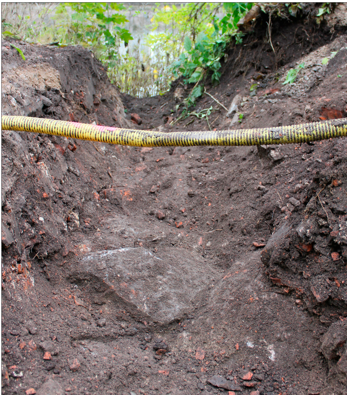
Figur 6. Murkonstruktion 100 och rester av utfyllnadslager 101 i schaktväggarna till schakt 1. Foto från sydväst.
