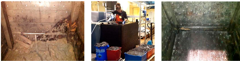
Bild 10-12: Sumpens insida under rengöringsarbetet.
