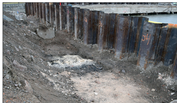
Figur 6. Norra delen av avlastningsschaktet innan övertäckning. Här syns de kulturlager (6191, 6219, 6197) som framkom på en nivå av cirka 0,5 m.ö.h. Foto från sydväst.
