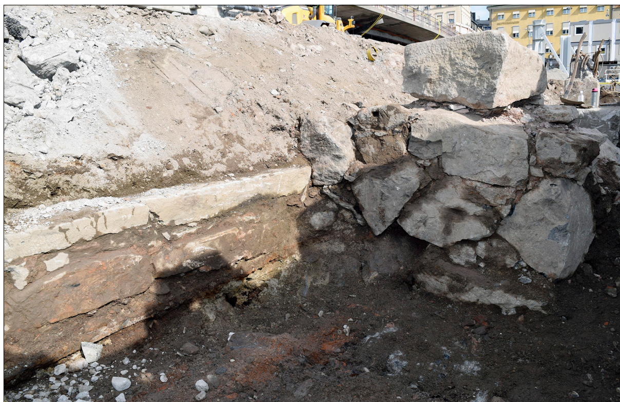
Figur 9. Mur och kajkant (6193) tillhörande Polhems sluss från 1750-talet. Foto taget från sydöst.
