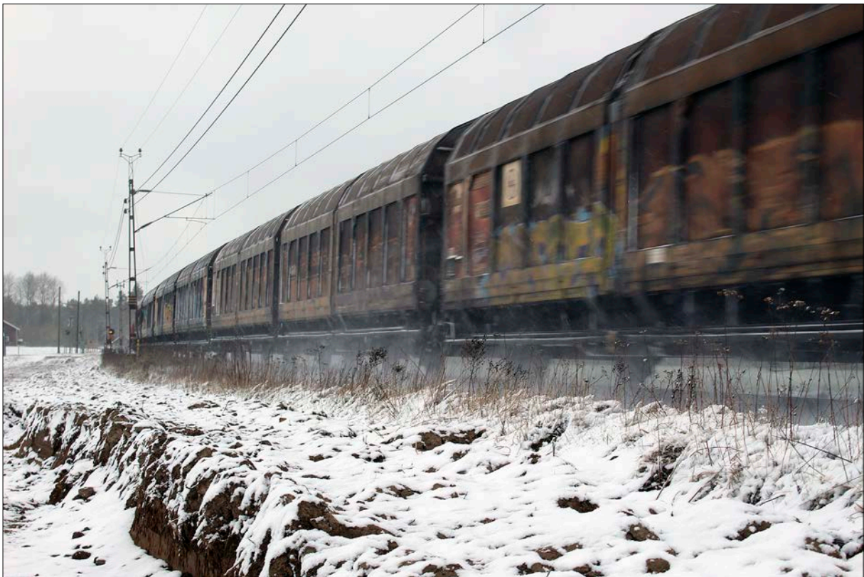
Figur 4. Arbetet utfördes direkt invid järnvägen.
