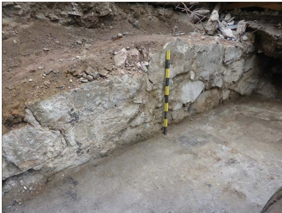
Figur 13. Muren (2000) och stenläggningen (2001) som framkom vid schaktningen kan härledas till Christopher Polhems sluss från 1755. Foto från SV.
