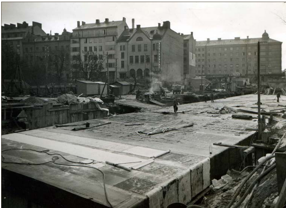
Figur 7. På bilden syns det tak av betong som göts ovanpå Katarinatunneln vid Björns trädgård. Bilden är tagen från nordväst år 1933 (Stockholmskällan, LB_SSA_3319_02_063).
