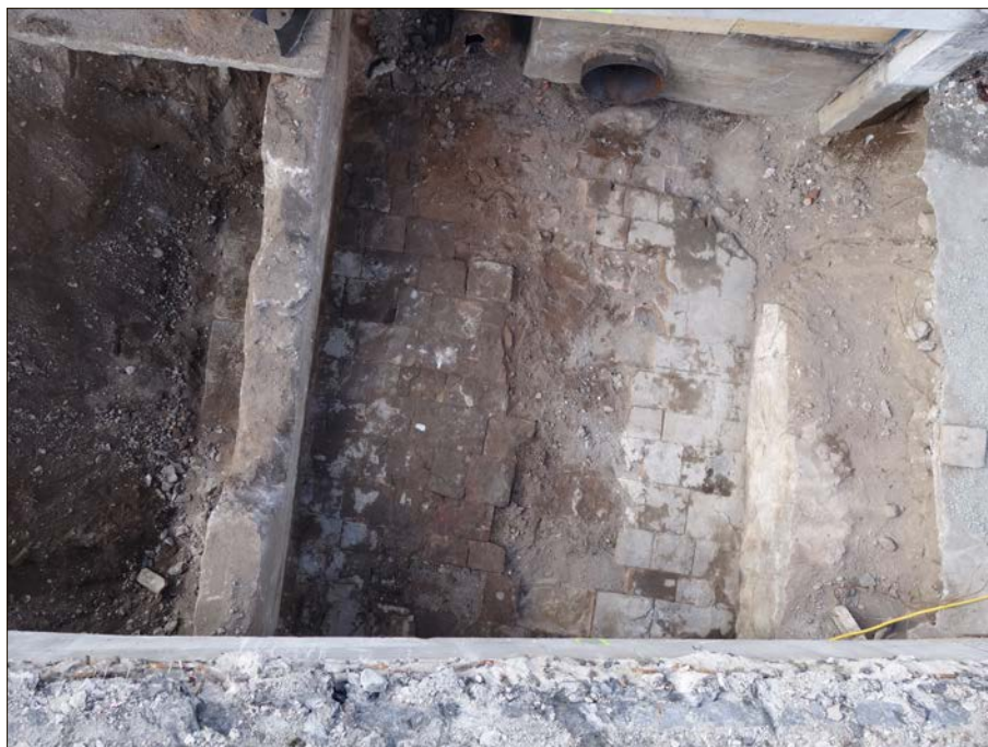
Figur 11. Översiktsbild över en del av de lämningar som framkom vid Västra terrassrampen efter att vatten- och gasledningar avlägsnats. Ytorna längs Polhems sluss från 1755 var belagda med stenplattor av vilka en del kan ses centralt i bilden (2001). Till höger i bild ses muren till den långsmala byggnaden gröna gången (2000) från samma tid. Muren till vänster (2003) tillhör den basarbyggnad som uppfördes 1856.
