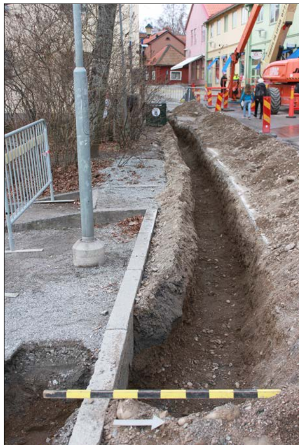
Figur 4. Schaktet utmed Stora gatan. Foto från Ö.
