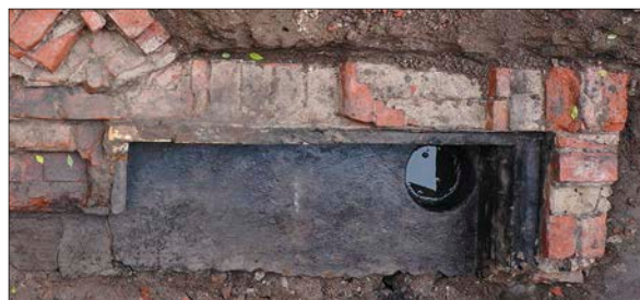
Figur 5. Den östra delen av tegelkonstruktion 101 tillsammans med ugnskonstruktion 106. Foto från söder.
