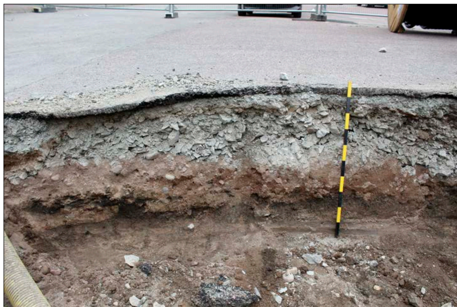
Figur 10. Profil i norra schaktväggen i schakt 1. Lager 102 syns som en mörk sträng cirka 0,65 meter under markytan. Foto från söder.
