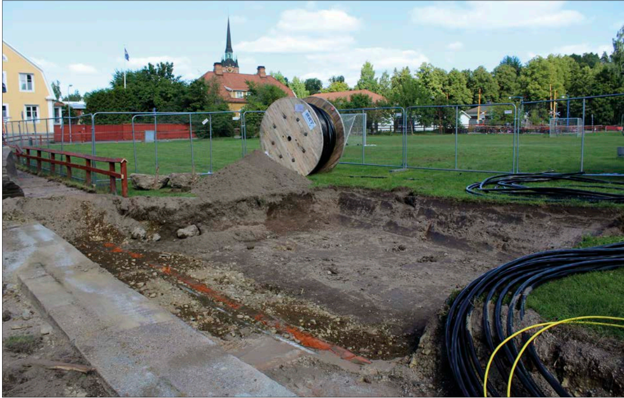
Figur 14. Schaktet i kanten på Östra skolans tomt. Foto från sydväst.
