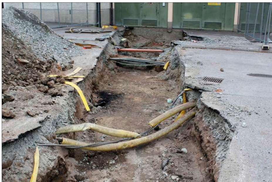
Figur 8. Schaktet närmast Länsstyrelsens byggnad i Kansliet 20. Foto från öster.
