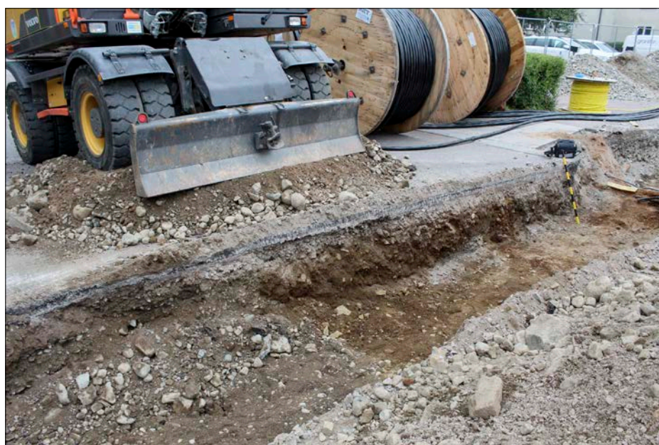
Figur 11. Schaktet genom Trotzgatan. Foto från nordost.
