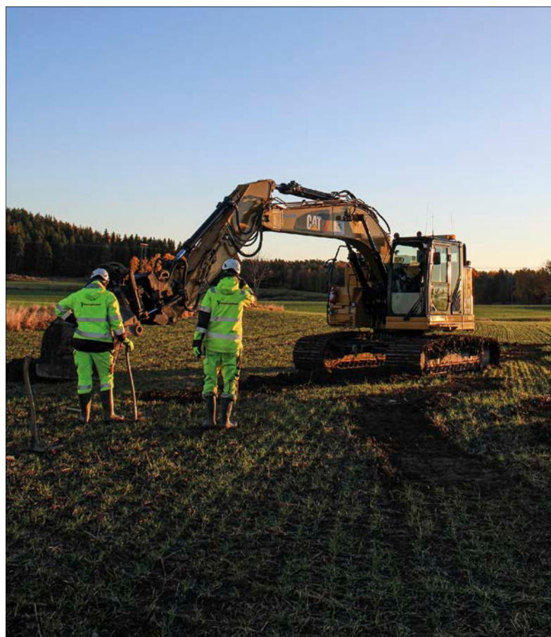
Figur 10. Sökschaktning i höstgryning. Foto från norr.
