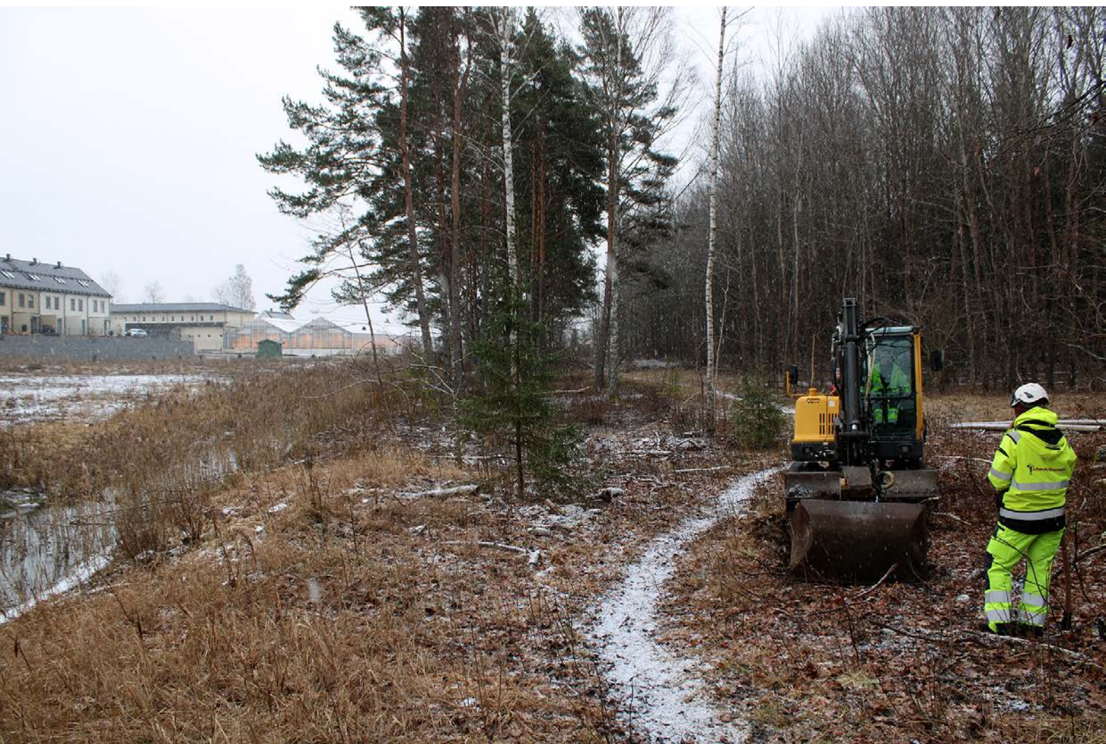
Figur 7. Sökschaktning pågår i snöregn invid ett vattendrag i utredningsområdets norra del. Foto från väster.
