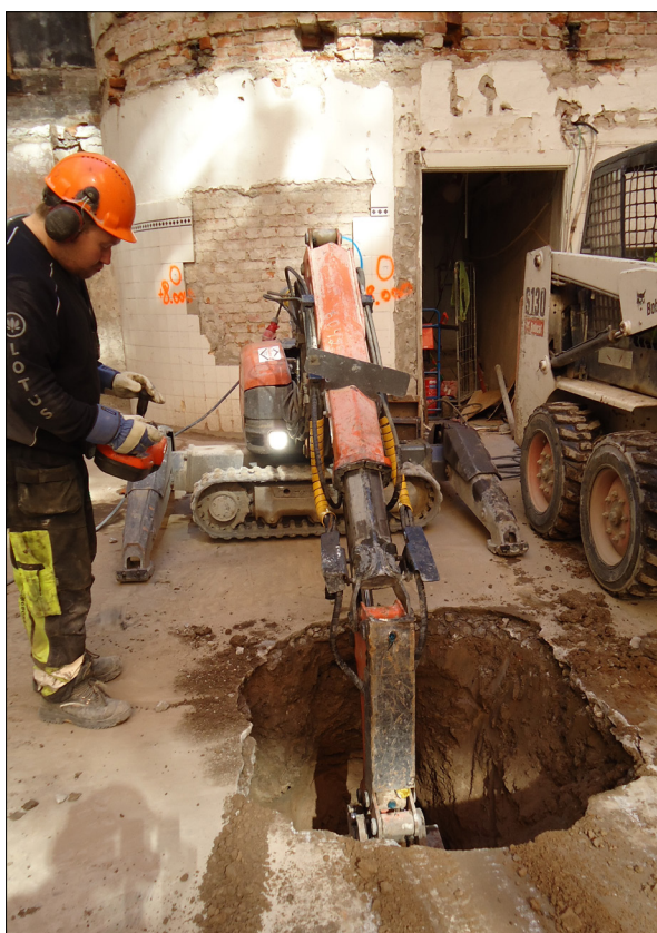
Figur 2. Schakt för plint nr 1 undersöks.
