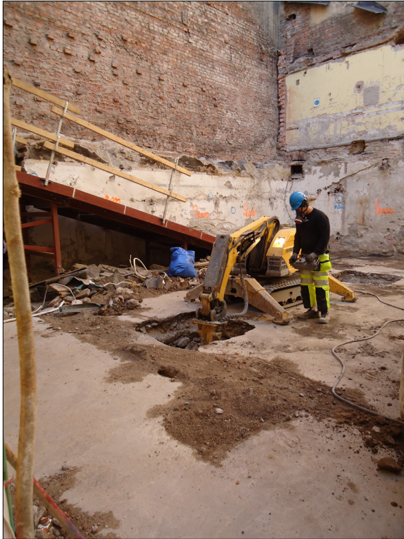
Figur 3. Schakt 2 undersöks och schakt 3 ses i bakgrunden.
