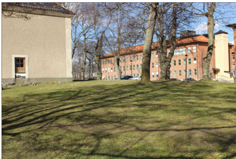
Figur 23. Trädgårdsmästarens fähus låg strax söder om magasinet/stallet som ingår i byggnadsminnet. Foto från SV.
