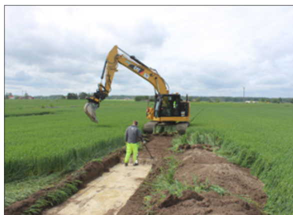
Figur 7. All matjord detekterades skiktvis i de upptagna schakten. Då grödan var en halvmeter hög vid utredningstillfället var de översta 0,1-0,15m tvungna att banas bort innan detekteringen. Foto från Ö.
