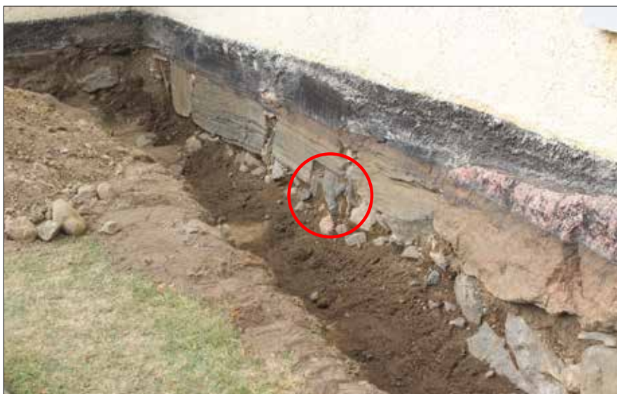
Figur 6. Inre delen av långhusets södra sida. Stenarna (103) under kyrkans övre grundläggning (101) är så gleslagda och små att de knappast kan ha utgjort en mur i befintligt skick. Stenarna i 101 var inte synliga ovan mark i väst. Notera även stenen som är huggen för att passa in i den underliggande konstruktionen (se röd markering). Foto från SO.
