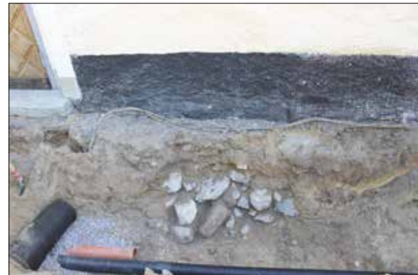
Figur 12. Sandlagret i nordväst täckte den eventuella bogårdsmuren (121) och gravarna i väst (117–120). Muren tycks också ha legat under den nuvarande västra gaveln. Foto från V.
