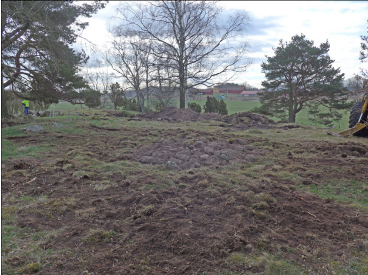
FIGUR 6. STENSÄTTNING 101 EFTER ATT SCHAKTET LAGTS IGEN. STENSÄTTNINGEN ÖVERTOVRADES INTE UTAN SPARADES SÅ ATT DEN ÄR SYNLIIG. FOTO FRÅN NORR.
