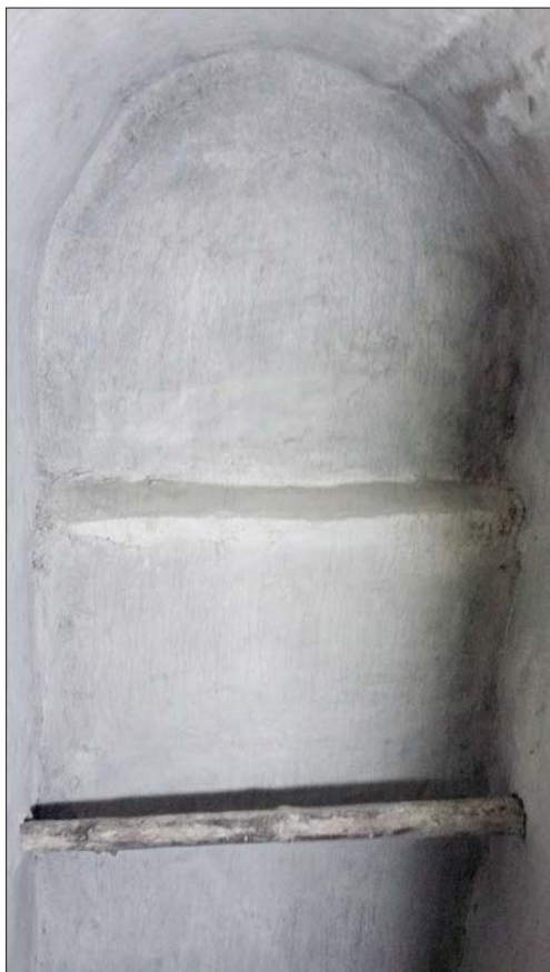
Figur 54. I nischen bakom altaruppsatsen löpte två tvärgående runda träribbor. Har troligtvis varit avsedda för upphängning av något. Dessa finns kvar men hamnade bakom den nya isoleringen.
