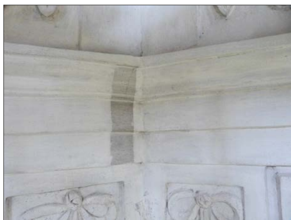
Figur 11. Referensyta i Hackerska gravkoret som visar putsytan före konservering.
