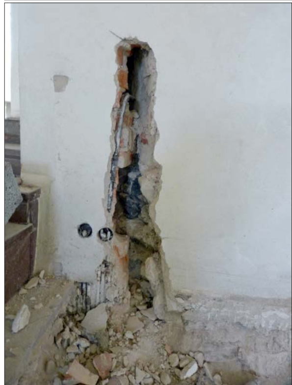
Figur 57. På ömse sidor om trappan till Hackerska togs murslitsar upp för ny rördragning till värme och el. Tidigare rör löpte på samma ställe, men var inte lika utrymmeskrävande som de nya rören.
