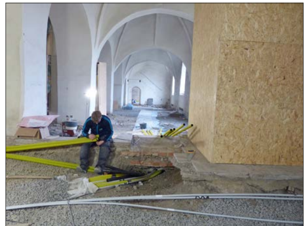
Figur 17. Rörläggningen tog mycket tid. Här syns övergången mellan norra sidoskeppet och koret som löper i schakt under korkanten.
