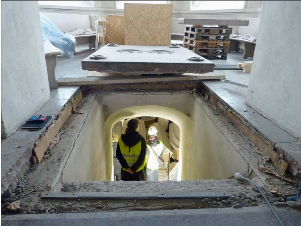
Figur 61. Den stora hällen lyftes bort över nedgången till Hackerska.
