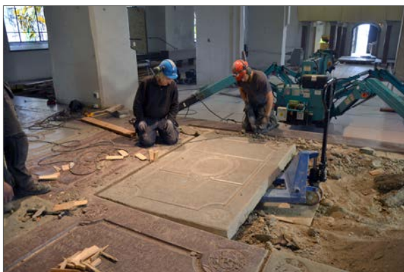
Figur 25. Korgolvets hällar flyttades ner till sidoskeppen. Arbetet utfördes med stor försiktighet.
