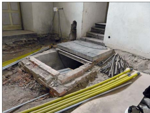
Figur 81. Ena halvan av gravhällen över nedgången till Lovisins gravrum är bortlyft. Hål för nya rör togs i tegelmurverkets ena hörn. Radonrören är ännu inte på plats.
