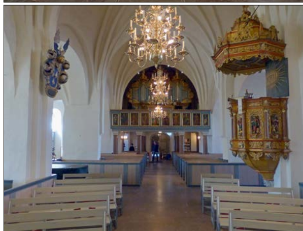
Figur 39. Kyrkorummet från öster före och efter renovering. Stolarna närmast koret har blivit ersatta med nya bänkar.
