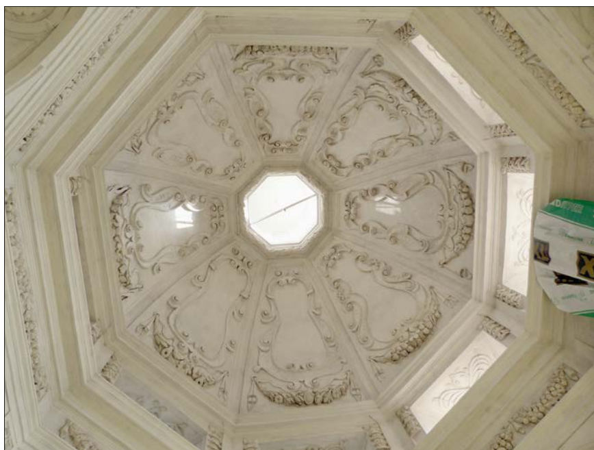
Figur 10. Hackerska gravkoret efter konservering. Rengöringen gav nytt liv åt den dekorativa stuckaturen.
