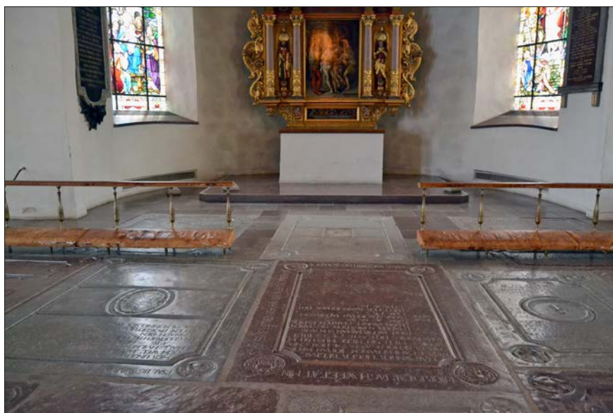
Figur 23. Korgolvet med gravhällar före renovering. Altarringen rengjordes och kläddes med nytt skinn av samma typ som de omklädda stolarna. Det murade altaret i bakgrunden målades i en mörkare grå nyans i samklang med altaruppsatsen.
