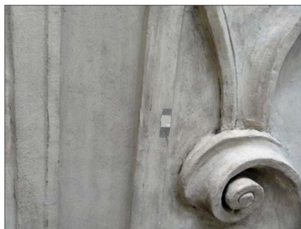
Figur 12. I samband med konserveringen av Hackerska koret iaktogs äldre färgspår. Den grå färgsättningen härrör troligtvis från 1800-talets andra hälft.
