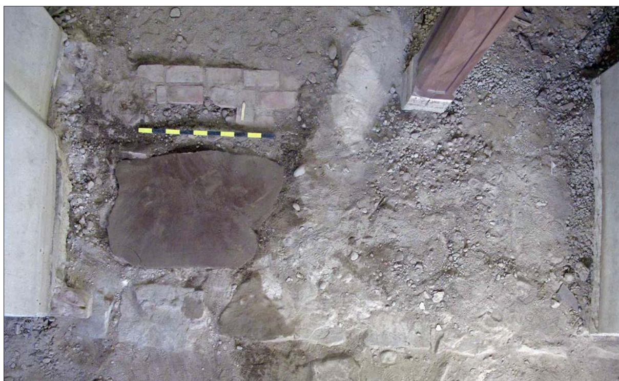
Figur 31. Kyrkans ursprungliga ingång med en röd kalkstenschäll på golvet och block med dörrupphängning längst ned till vänster.
