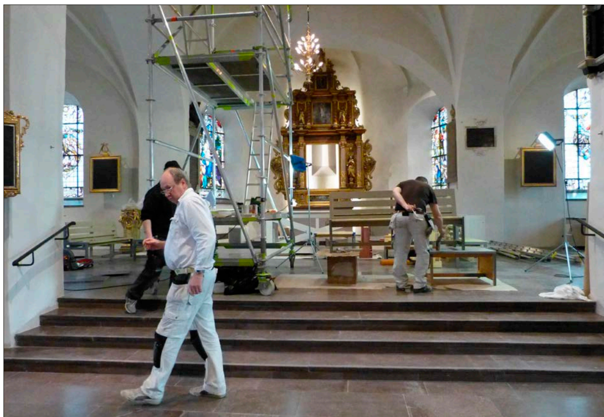
Figur 1. Full aktivitet i koret med målning av ny inredning och konservering av altaruppsats. Lägg märke till den igensatta fönstersmygen som skyttar i öppningen för den tillfälligt borttagna altartavlan.
