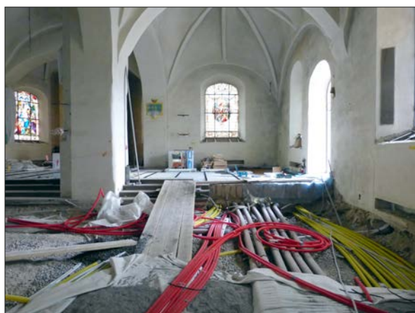
Figur 20. Södra skeppet under pågående rödrdragning. I makadamen döljer sig de kraftiga radonrören.
