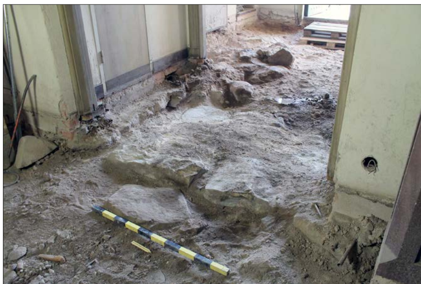
Figur 33. Rest av den äldsta tornmuren i övergången mellan tornrummet och mittskeppet. Foto från nordost.
