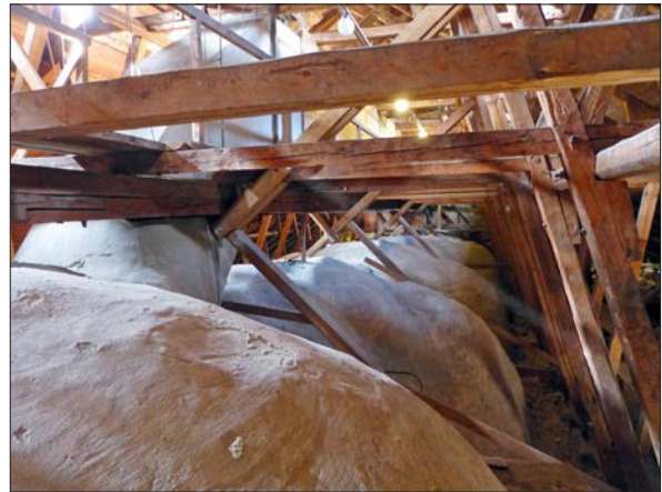
Figur 58. Mittskeppets medeltida valvhjässor var under en kort period frilagda från isolering. Tegelytan var slammad med lös, borstad kalkbruk. På enstaka ställen tätades mindre sprickor. Valvkapporna är en halv tegelsten tjocka.
