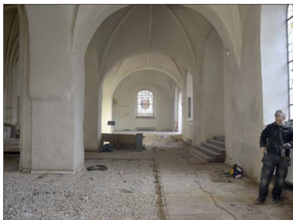
Figur 19. Södra skeppet efter friläggning av bänkkvarterens trägolv och gångarnas kalkstensplattor.
