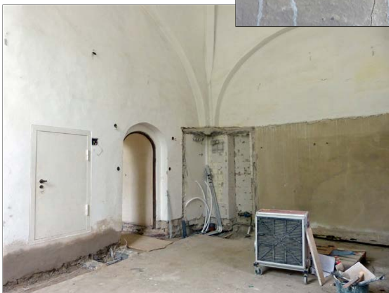
Figur 7. I sakristians sydöstra hörn var valvet sedan tidigare avlastat med en tvärgående järnbalk. Befintligt ventilationsrör i hörnet löper vidare upp på sakristians vind. En ny toalett ersatte den tidigare i samma hörn.
