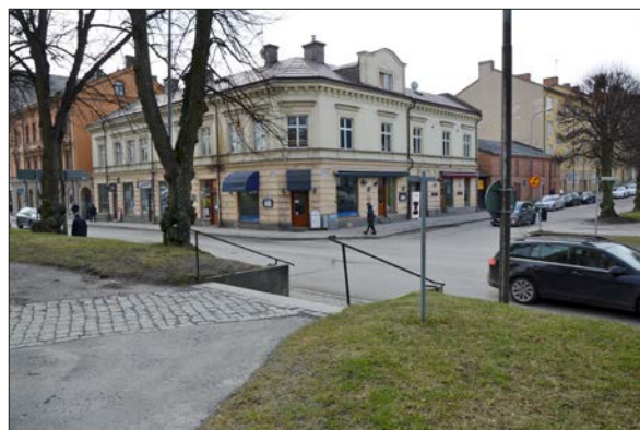
Figur 78. Utvändig trappa före ombyggnad.
