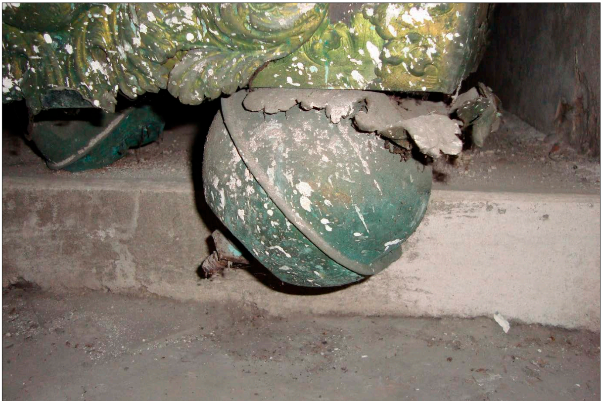
Detalj av huvudgaveln nedre parti. Foto: Cai Zetterström
