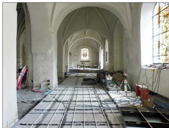
Figur 21. Södra skeppet. Isolering och golvvärmror är på plats.
