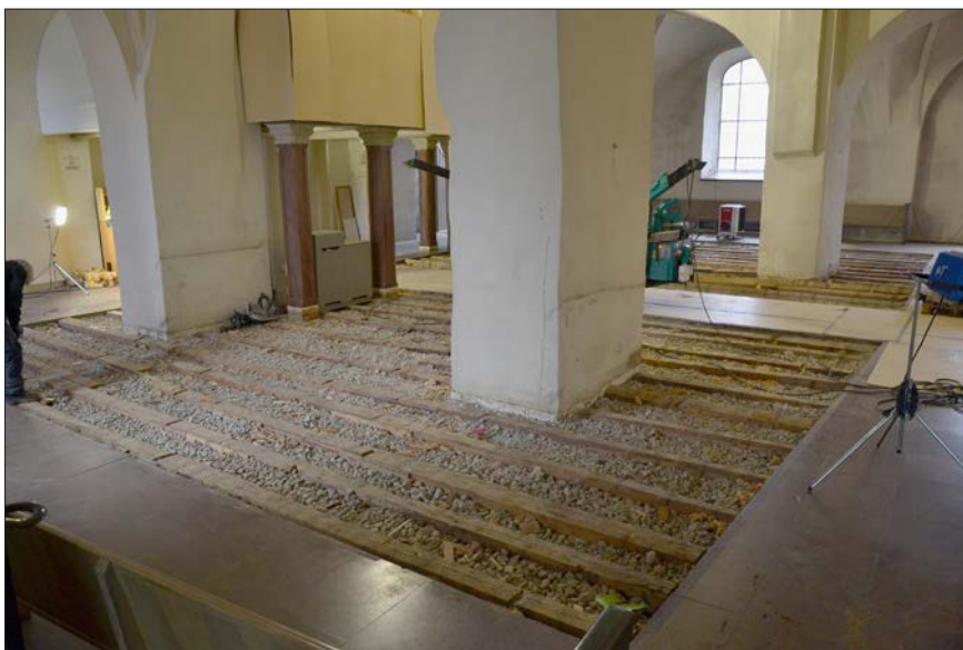
Figur 31. Vy över kyrkorummets västra del från söder. Bänkkvarterens utbredning minskades. Både äldre träbjälklag och golvbrädor återanvändes vid återläggningen.
