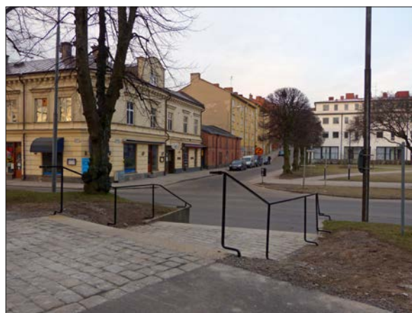
Figur 79. Utvändig trappa efter ombyggnad med tillägg av ytterligare en trappdel.
