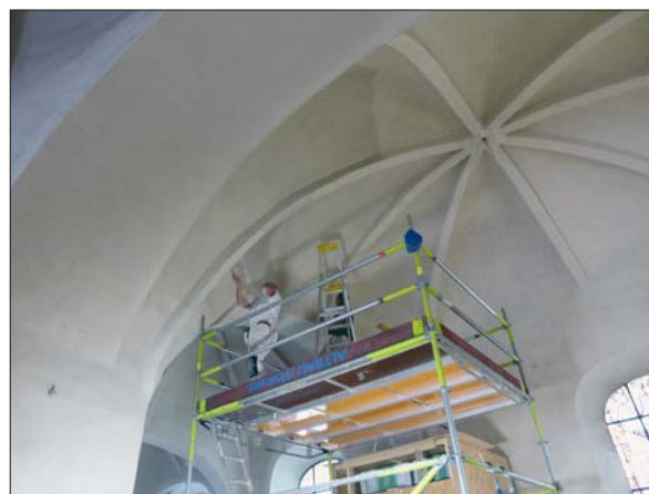
Figur 2. Rengöring av mittskeppets valv. I valvkapporna framträder de rengjorda ytorna som ljusare.
