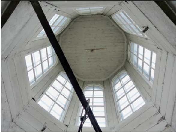
Figur 15. Lanterninen i Hackerska före målning. Alla trätytor nymålades i en ljusgrå nyans, liknande underliggande färgspår.
