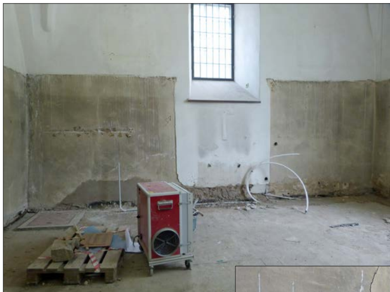
Figur 5. Sakristians väggar som de såg ut bakom skåpinredningen. Här framkom äldre färgspår som troligtvis har varit någon form av bröstning. Dessa ytor är återigen dolda av skåpinredning.
