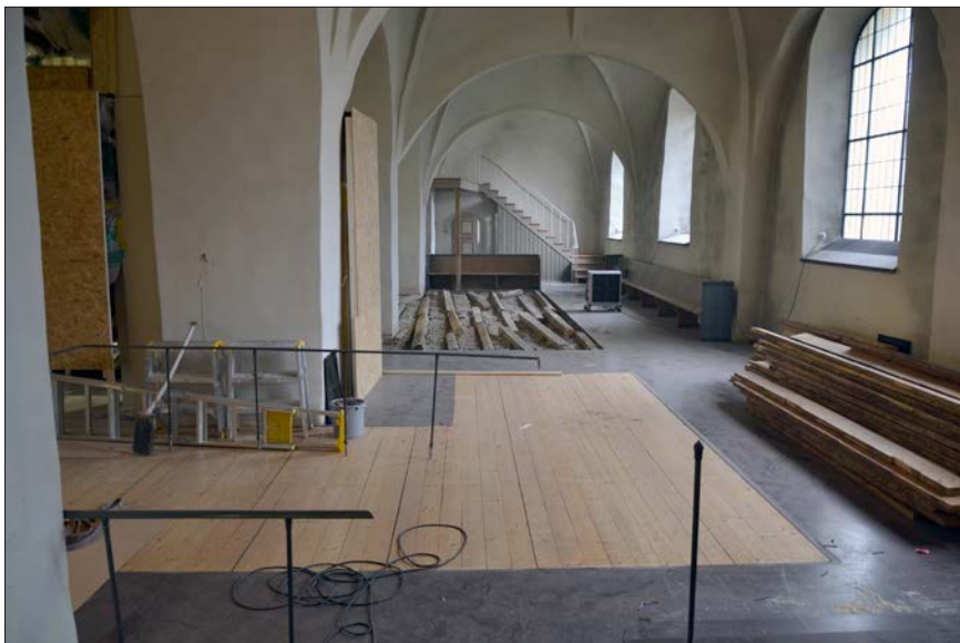
Figur 30. Bänkkvarterens trägolv justerades efter den nya planeringen med nya funktioner i sidoskeppen.
