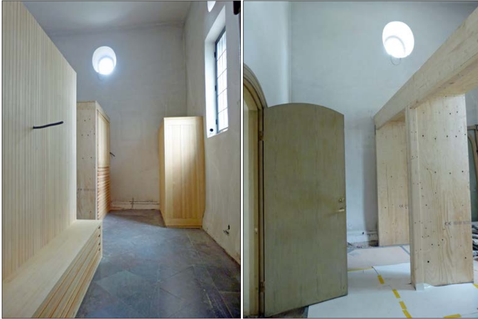
Figur 43. Inredningen är under framväxt i Lovisinska. Den nya mellanväggen är funktionellt utformad med integrerade skåp och sittplatser nedtill och genomsiktligt glasparti upptill.
