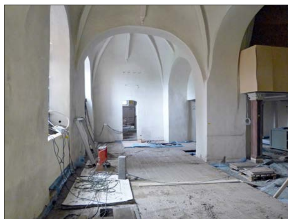
Figur 22. Södra skeppet. Golvet är gjutet på nytt.
