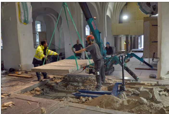
Figur 26. De tunga hällarna lyftes med kran.
