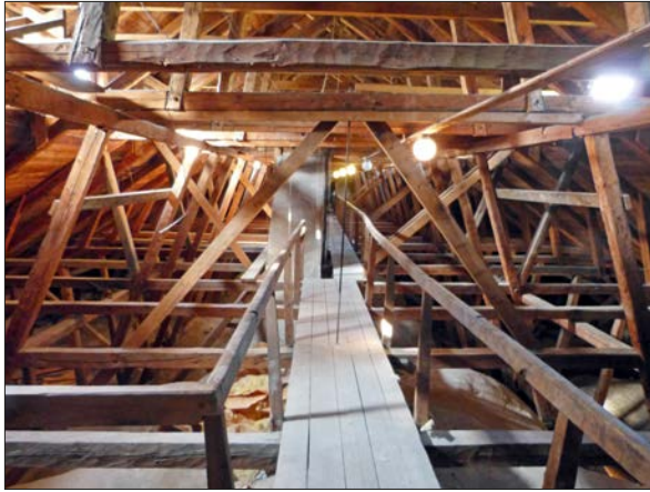
Figur 59. Vinden före tillbyggnad av nya spänger och kronhissar.
