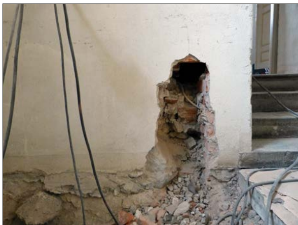
Figur 56. Håltagning för ny rördragning mellan kyrkorum och Lovisinska. Slitsar av samma storlek utfördes på bägge sidor av dörren. Här var upptaget och igenmurat av samma skäl även på 1960-talet.
