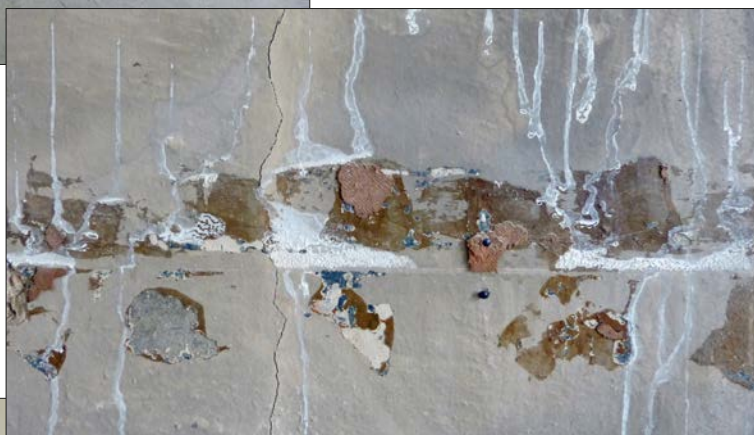
Figur 6. Underst på den släta kalkputsen fanns först en vit kalkfärg därefter följde mellanmörk blå, vit, mellanmörk ockra och slutligen den yttersta beige färgen.
