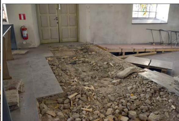
Figur 28. Gravhällar och golv är lyfta i korets södra del. Just här satt hällarna i ett hårdare cementbruk.
