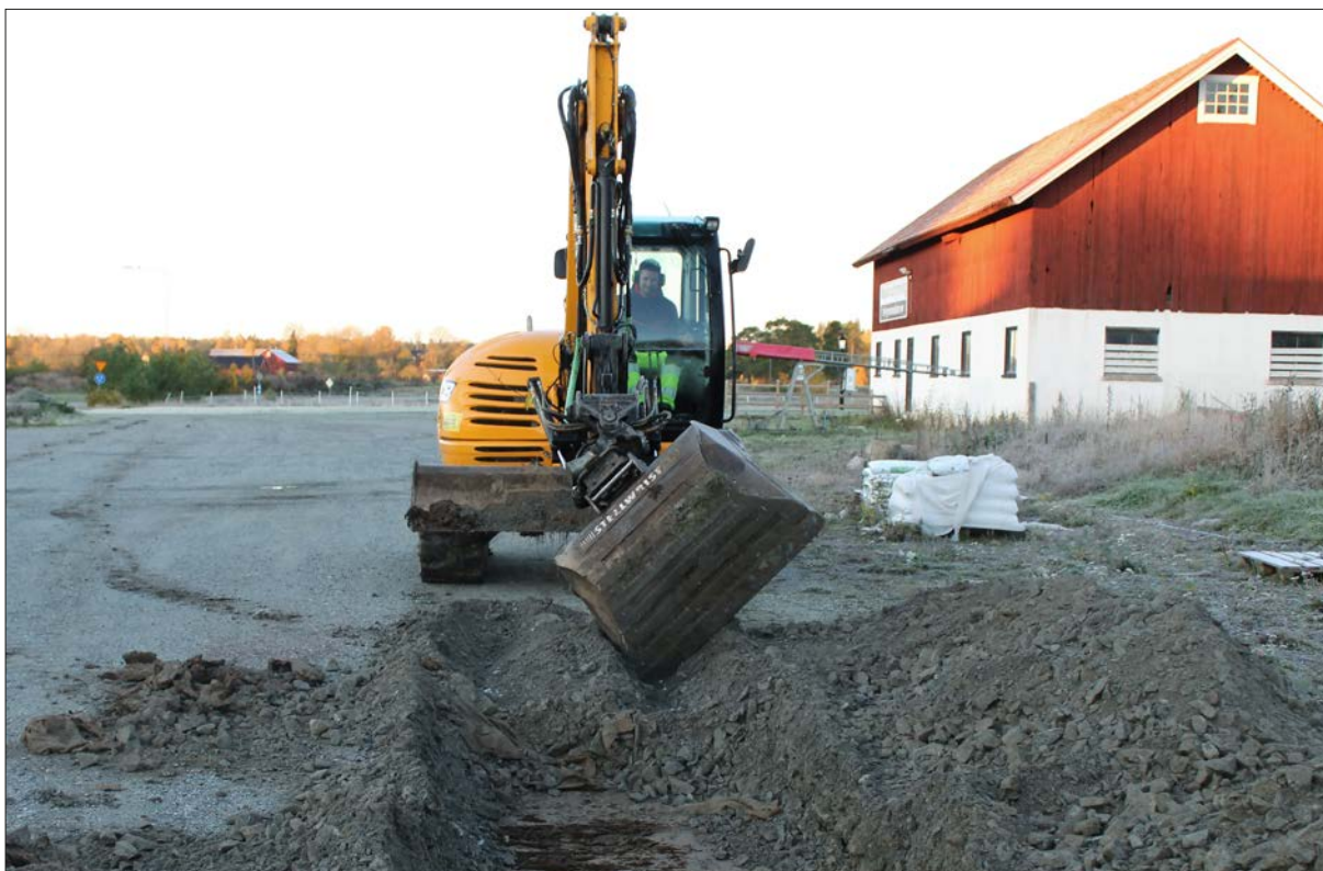
Figur 5. Sökschaktning på handelsträdgårdens parkering skedde genom borttagning av ett upp till 0,5 m tjockt lager grus med underliggande markduk. Foto från nordöst.
