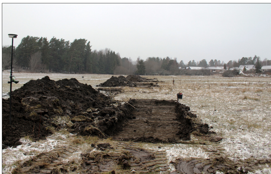
Figur 4. Undersökningsområdet under pågående förundersökning, fotograferat från SV.
