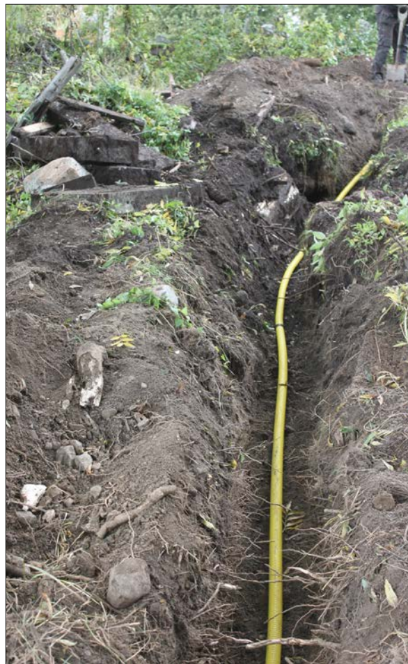
Figur 7. Schakt för elkabelledning från NNÖ.
