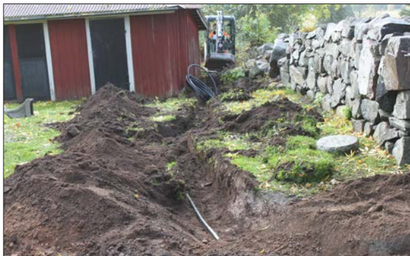
Figur 6. Schakt för sommarvatten från N.
