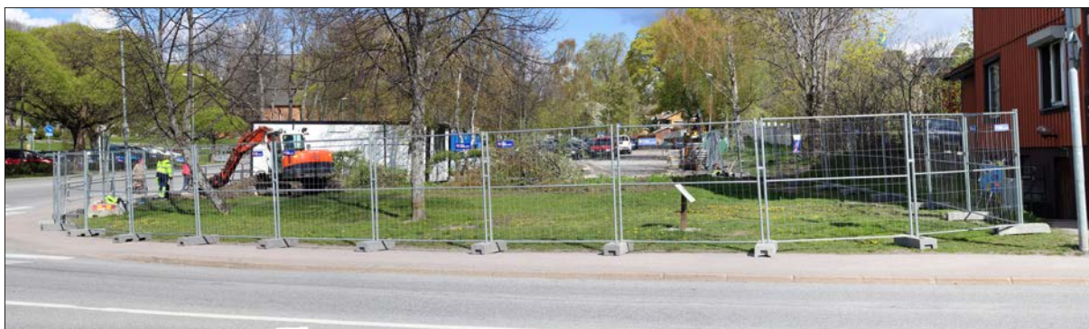
Figur 4. Undersökningsytan just innan vi satte skopan i marken en morgon i maj. Skylden i förgrunden visar den rekonstruktionsteckning av det tidiga Sigtuna som finns avbildad i figur 11. Bakom grävmaskinen skimtar Mariakyrkan.
