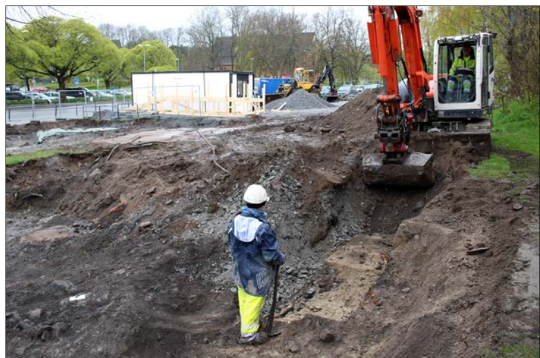
Figur 18. Alla störningar komplicerade avbaningen. Här tömtes ett igenfyllt förundersökningsschakt och gamla rör och en gjuten grund från macken kommer fram. Bakom arkeologen syns delar av det mörka avfallslager med mycket djurben som fanns i den sydöstra delen av ytan.
